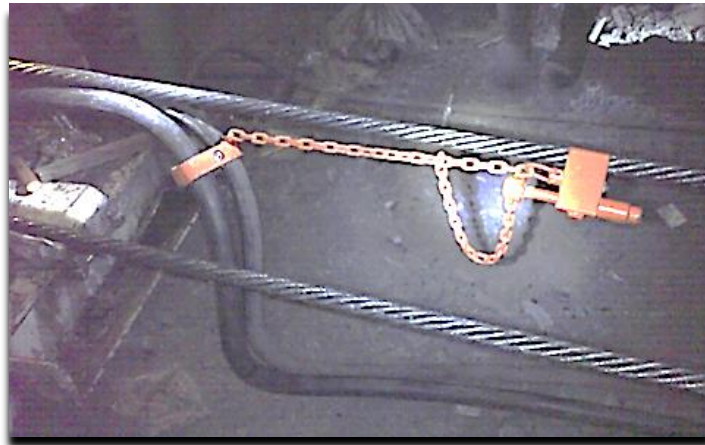
Şekil 4.6 Kablo ve hortumların halata montajı.
