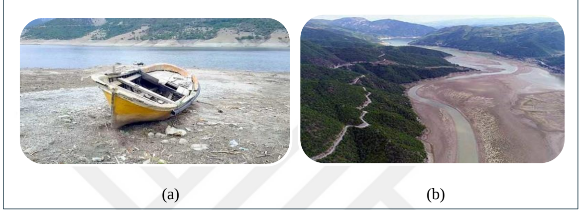
Şekil 3. Altinkaya Baraj Havzası'ndan görüntüler (a): kayığın karaya oturması, (b): suların çekilmesi (URL-5, 2024)
