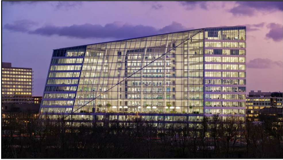
Şekil 4.33. Edge ofis binası
