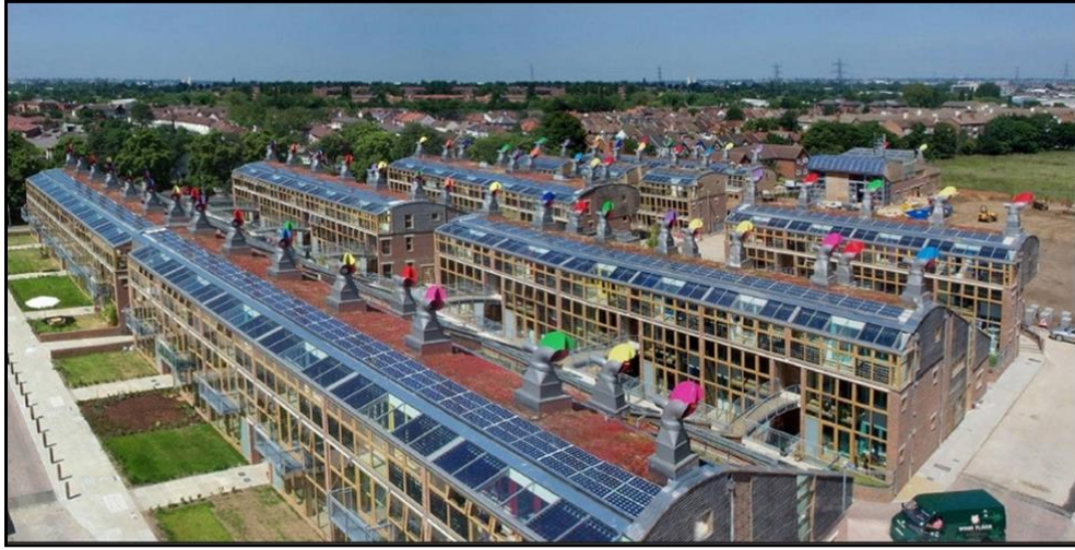
Şekil 4.36. Bedington sıfır enerjili konut kompleksi
