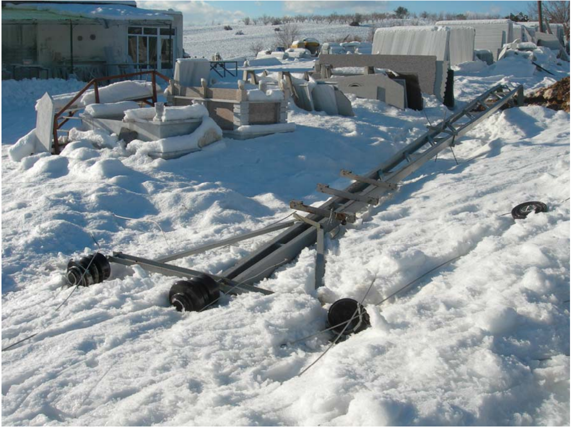
Foto 7: Bozkır’da 7 Ocak 2007 tarihinde meydana gelen kar yağışı nedeniyle yıkılan elektrik direği, (Foto Meslek Yüksek Okulu yolu kenarından çekilmiştir).
