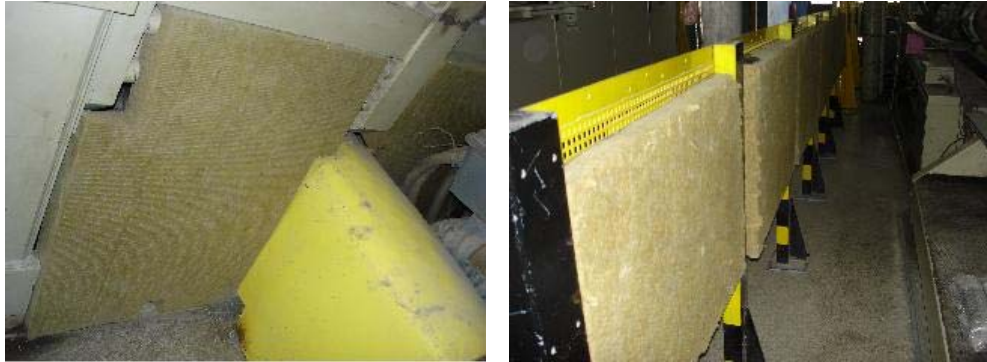
Şekil 3.33 Taşyünü ile perdeleme
