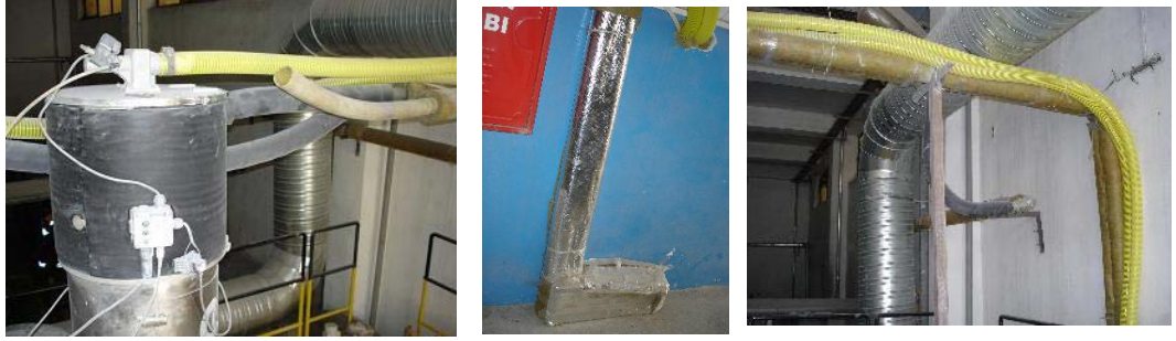
Şekil 3.32 Flex ve taşyünü kaplanmış hortum ve borular
