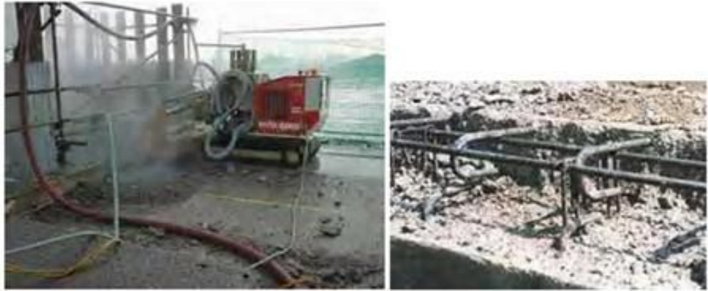
Resim 2.10 Su jeti ile yıkım
