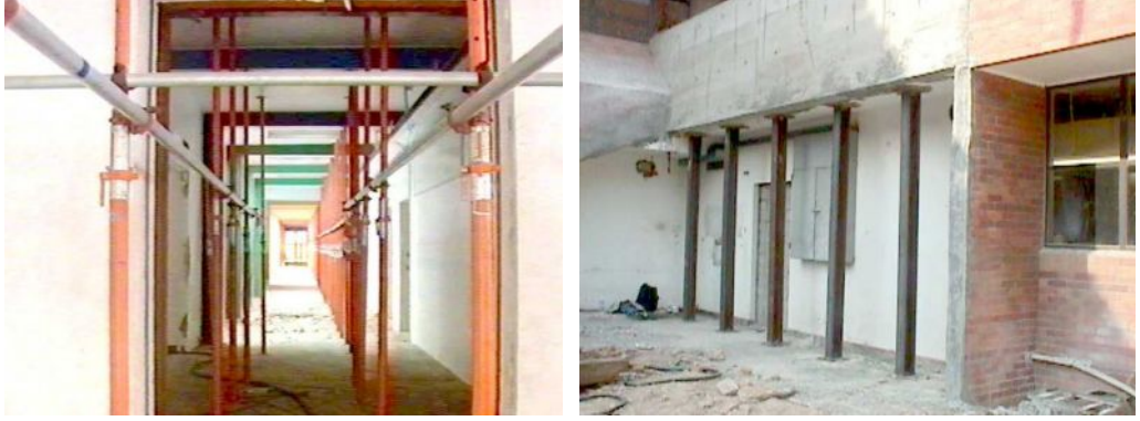
Resim 3.3 İskeleler kurularak yapının desteklenmesi
