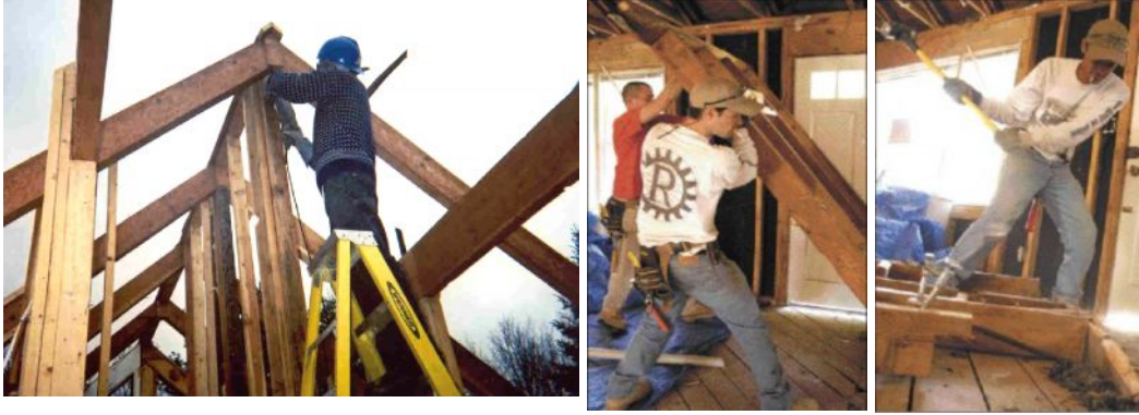
Resim 2.15 Ahşap yapıların ayrıştırılması
