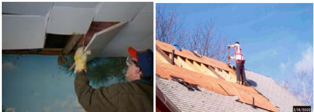
Resim 3.5 Çatıların ve asma tavanların ayrıştırılması
