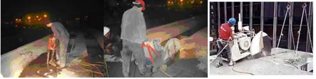
Resim 2.11 Kesme- Delme yöntemi
