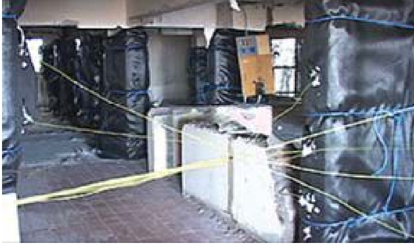
Resim 2.13 Betonarme kolonların sarılması [Koççaz,2006].
