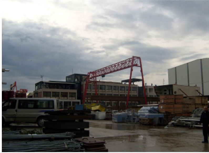
Resim 5.4 Yıkılan yönetim binası
