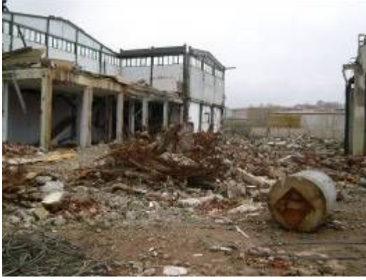
Resim 5.13 Çelik ve betonarme yapıların yıkımı
