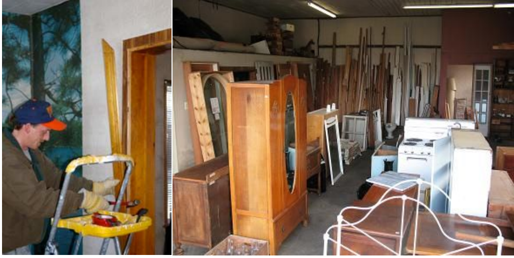
Resim 3.4 Tekrar kullanılacak yapı elemanlarının ayrılması ve depolanması
