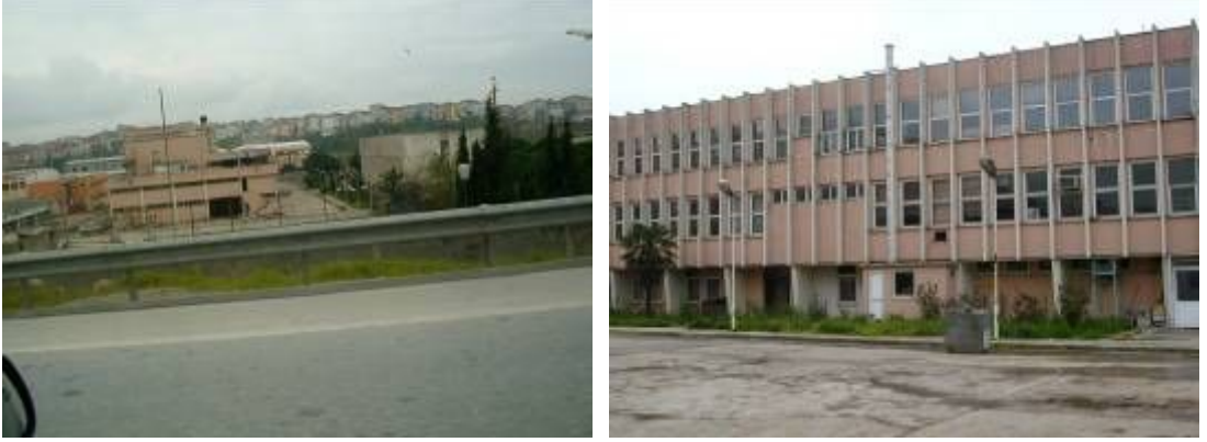
Resim 5.9 Yıkım kararı alınan fabrika
