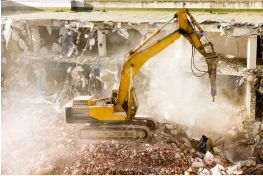
Resim 5.2. Yıkım makinelerinin yapıyı moloza dönüştürmesi
