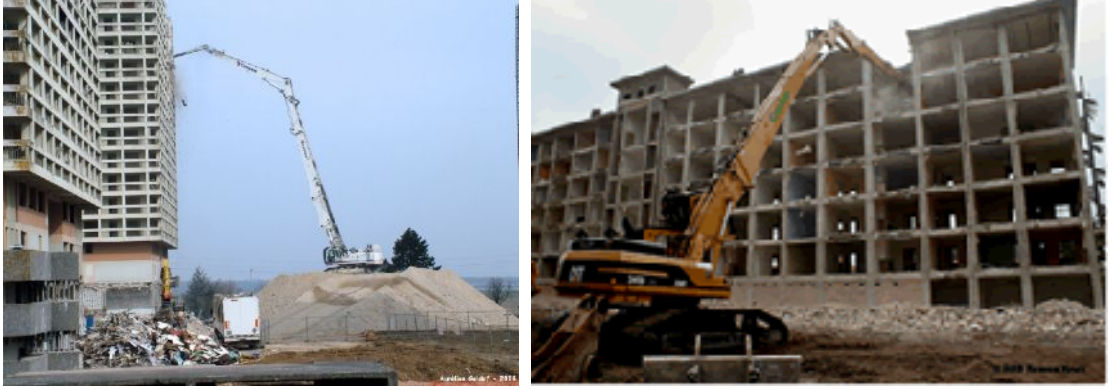
Resim 2.7 Yüksek erişimli makinelerle yıkım
