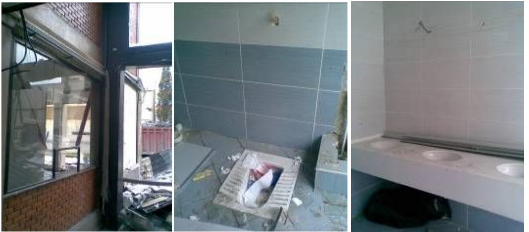
Resim 5.8. Tekrar kullanılabilir ve ayrıştırılmamış yapı bileşenleri
