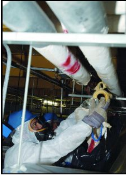
Resim 3.2. Asbestin sökülmesi
