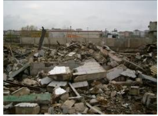
Resim 5.13 Çelik ve betonarme yapıların yıkımı
