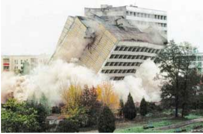
Resim 2.2 Yıkım esnasında atmosferik kirlenme
