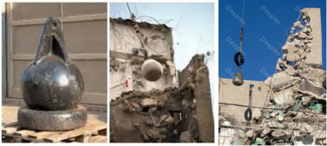
Resim 2.9 Çelik top ile yıkım
