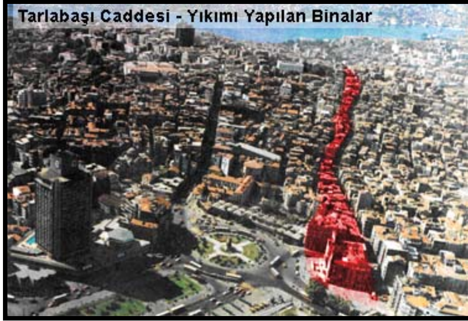
Fotoğraf 3.11 Tarlabası Caddesi, yıkım yapılan binalar
