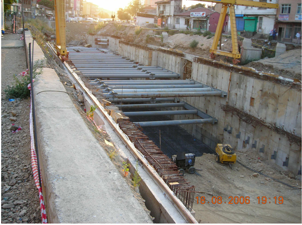
Şekil 3.31: Tünel yapımını gösteren fotoğraf-1
