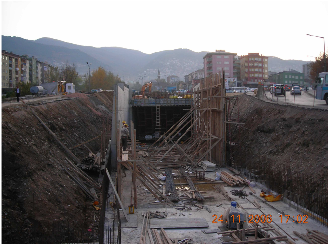
Şekil 3.32: Tünel yapımını gösteren fotoğraf-2
