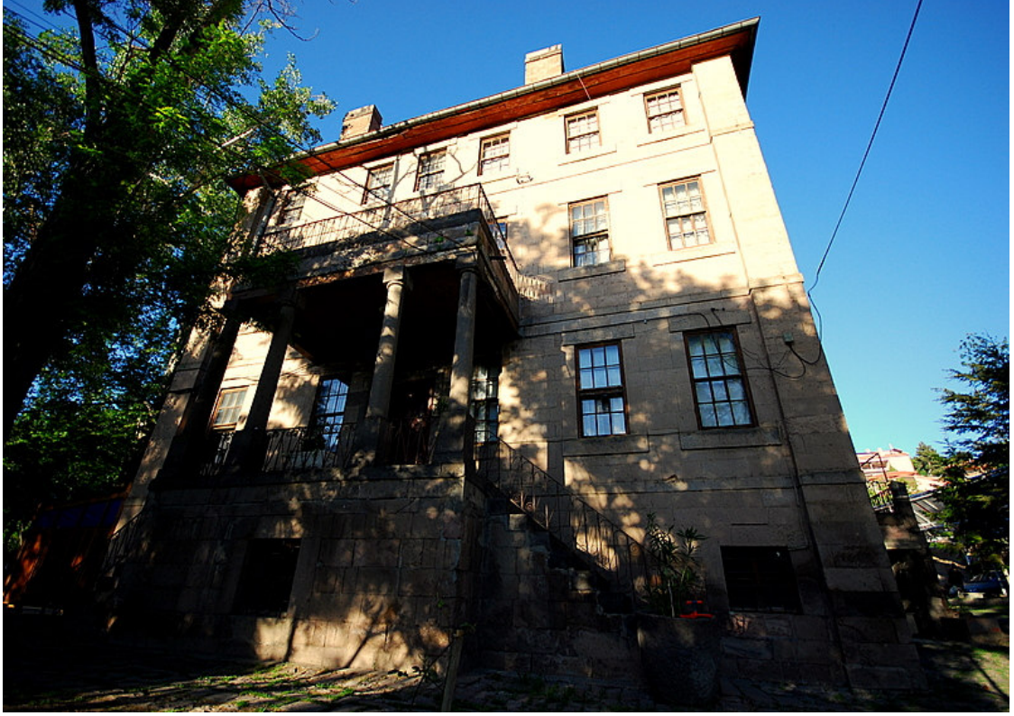
Ek-5.1.: Bugün Erciyes Üniversitesi Sosyal Tesisleri İçerisinde Yer Alan Talas Amerikan Kız Okulu Binasının Ön Cepheden Görünüşü
