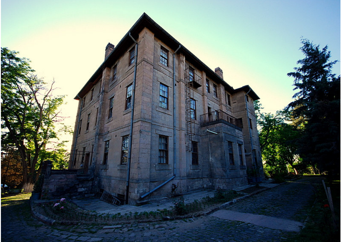
Ek-5.2.: Talas Amerikan Kız Okulu Binasının Arka Cepheden Görünüşü
