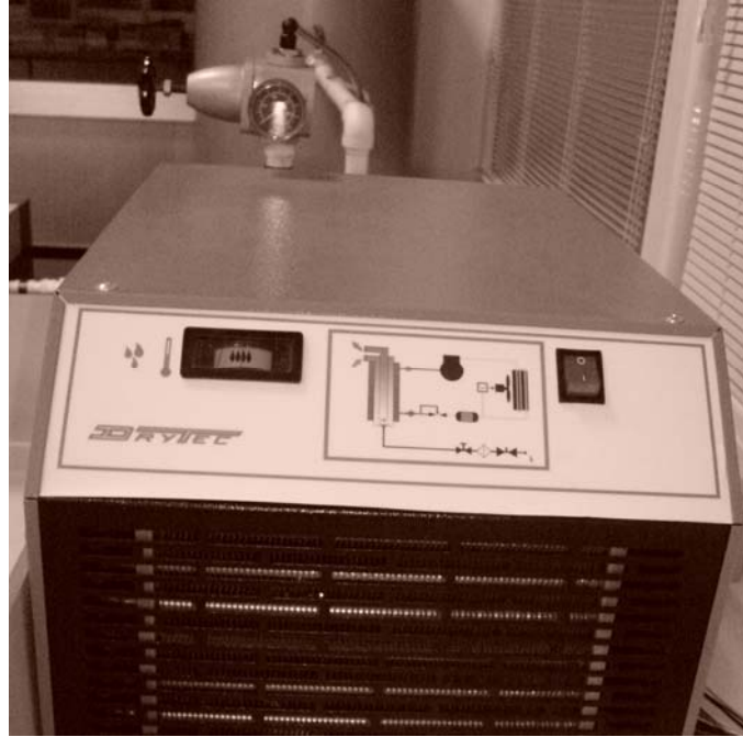
Şekil 2.7 Hava kurutucunun fotoğrafı
