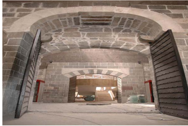
Fotoğraf 14 : Sultan Selim Külliyesi Onarım Sonrası*
