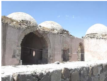
Fotoğraf 13: Sultan Selim Külliyesinden Bir Kesit*
