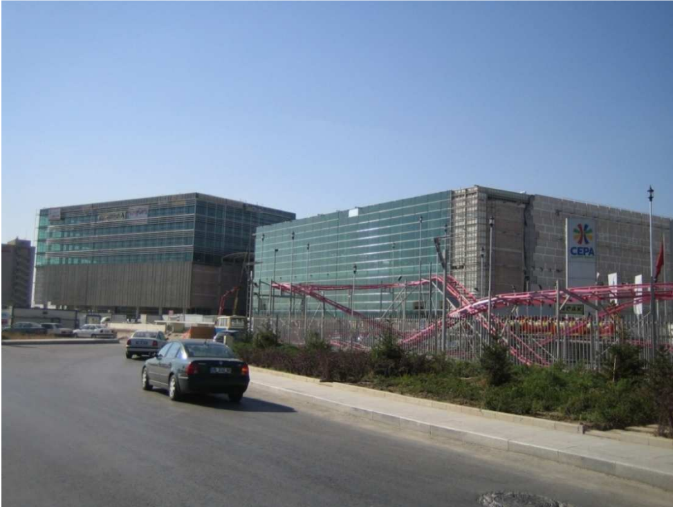
Resim 12.4. Cephe inşaat görüşü
