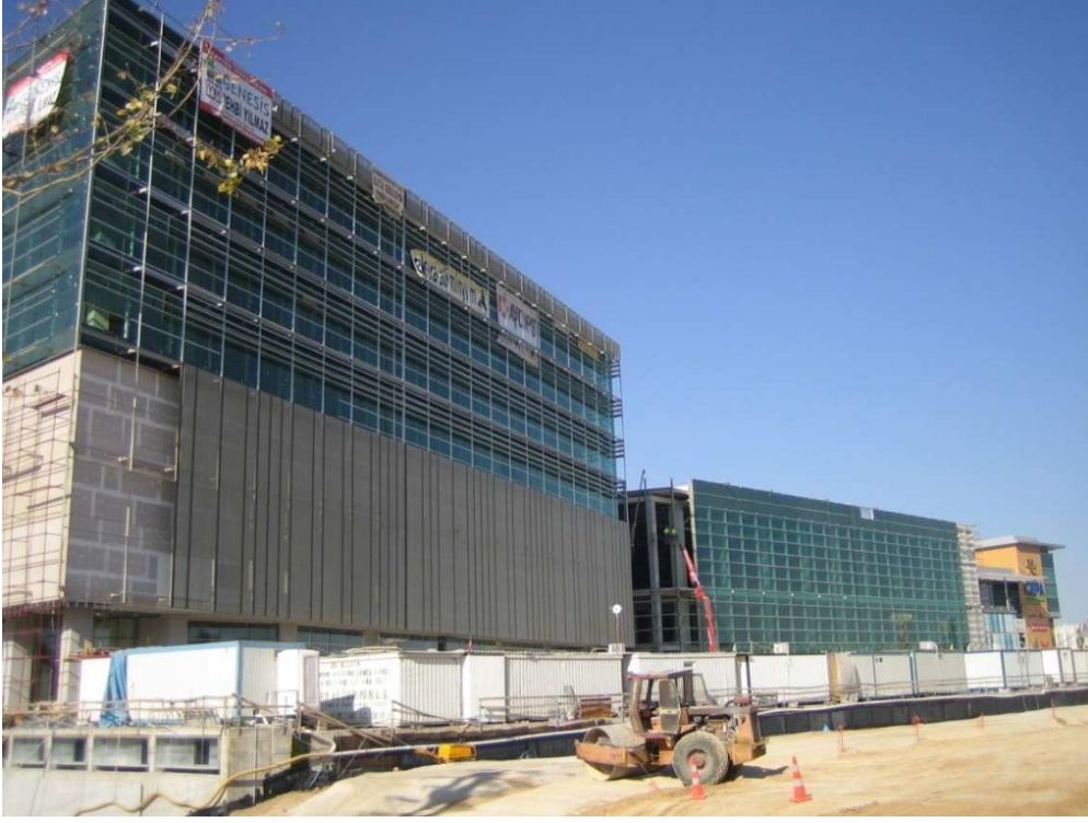
Resim 12.3. Cephe inşaat görüşü
