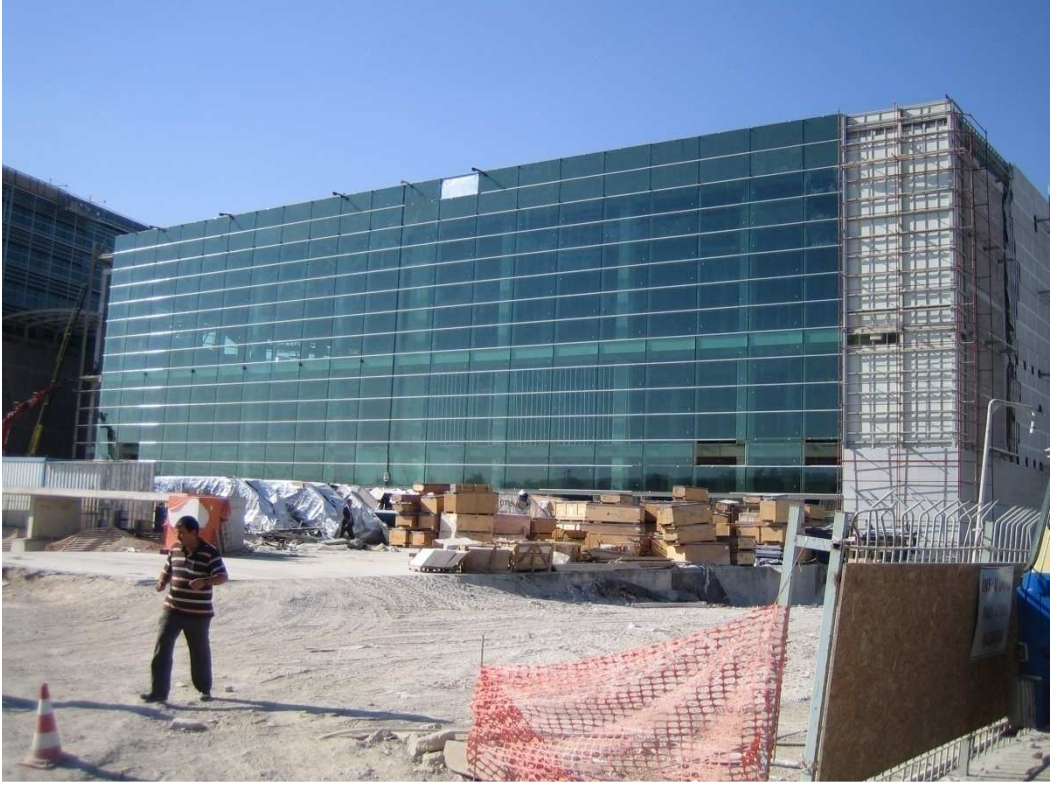
Resim 12.5. Cephe inşaat görüşü
