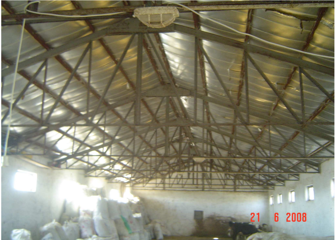
Şekil 22. Briket duvar malzemesi ve çelik konstrüksiyon kullanılan barınağın görünümü (Melikgazi)
