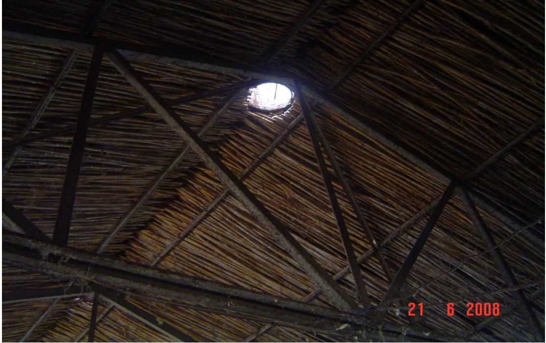
Şekil 24. Tavanında daire şeklinde bir baca bulunan tavan ve örtü malzemesi kamış kullanılan bir barınağın içeriden görünümü (Kocasinan)
