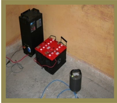
Şekil 4.4 Sistemin çalışır duruma getirilmesi
