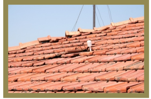
Şekil 4.3 Çatıya monte edilmiş GPS anteni
