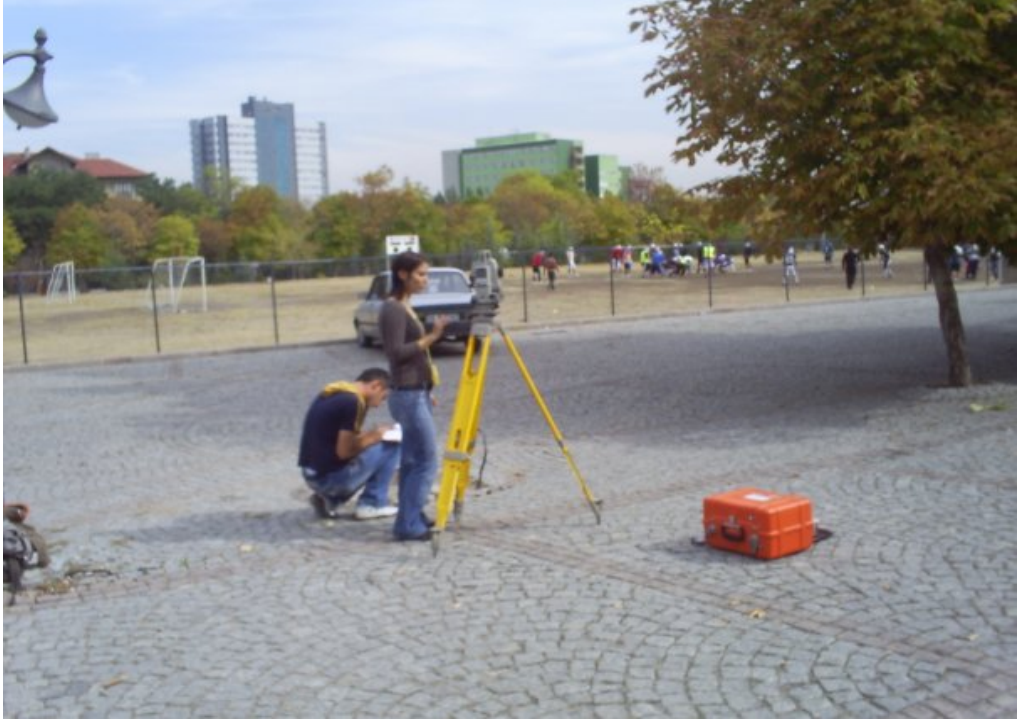
Resim 5.11. Kutupsal koordinat yöntemi ile (SET 2B Model Total Station) ölçüm yapılması
