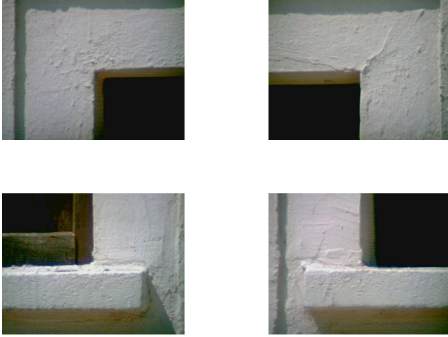
Resim 5.8. GPT 7000 i model total station üzerindeki dahili fotograf makinasından çekilen sadece bir pencerenin köşelerini gösteren 30 kat büyütölmüş fotoğraflar
