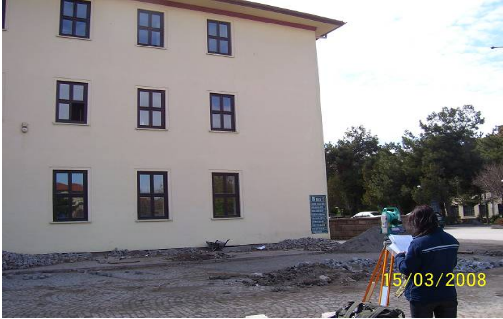
Resim 5.3. Rölövesi alınacak olan cephe
