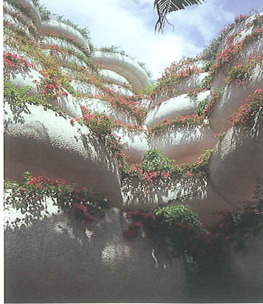
Şekil 2.43 Garden Wing balkonları (Belt Collins 2003)
