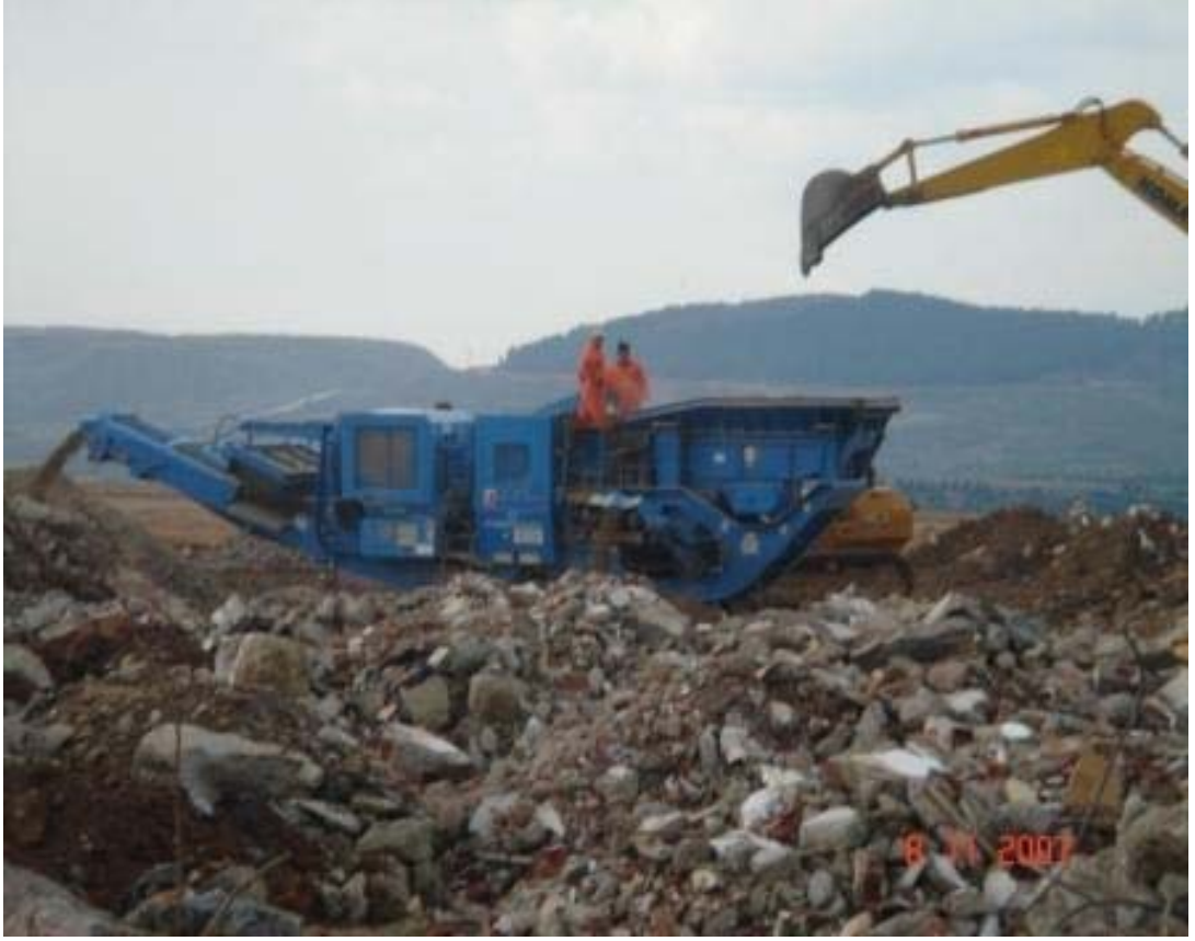
Resim 2.11. Tuzla Şekerpınar' daki geri dönüşüm merkezi ve beton kırma aracı(Ölmez, 2008).
