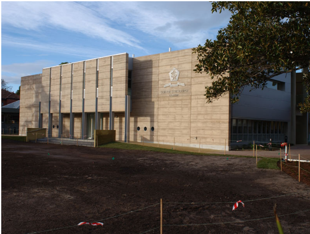
Resim 3.17. Geri dönüştürülmüş taşlardan yapılmış Lauriston Kız Okulu'nun Bilim ve Araştırma Binası, Melbourne, Australia, 2003. www.earthstructures.co.uk .
