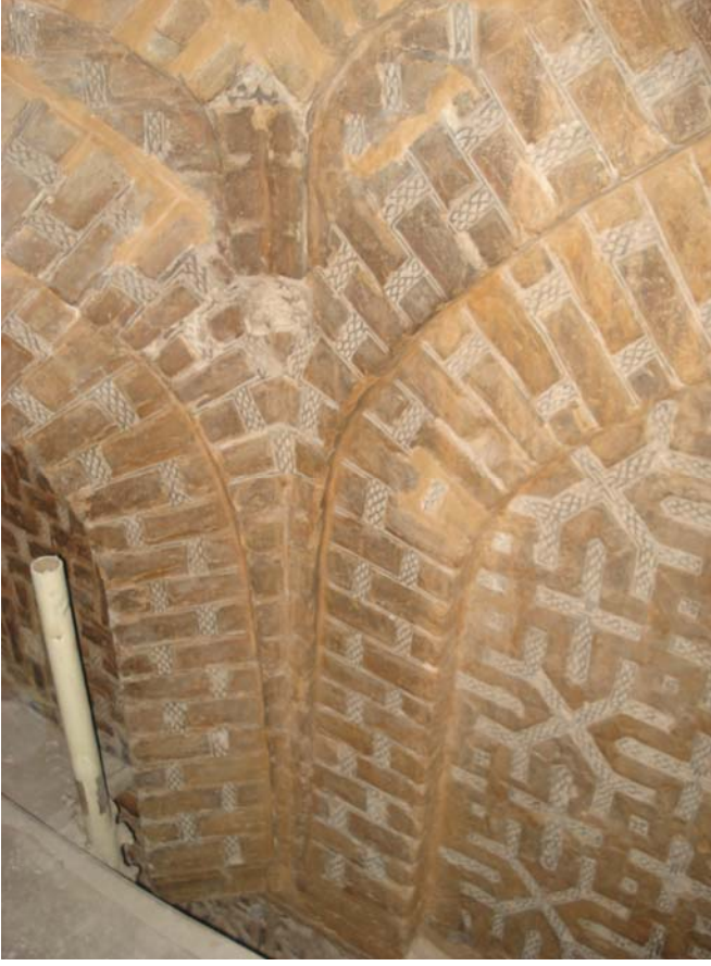
Resim 3.16. Tromplarda tuğla işçilik örneği [SOBOUTI, H., 2007]
