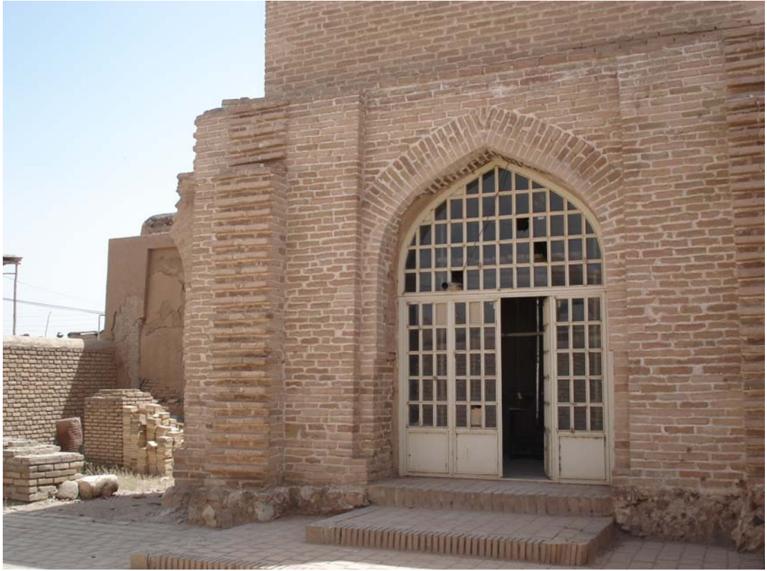
Resim 3.54. Kuzeydoğu cephesi'ndeki taşıyıcı duvar
