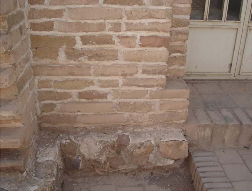
Resim 3.12. Taçkapıda subasman seviyesindeki kaba yonu taş sırası [SOBOUTI, H., 2007]
