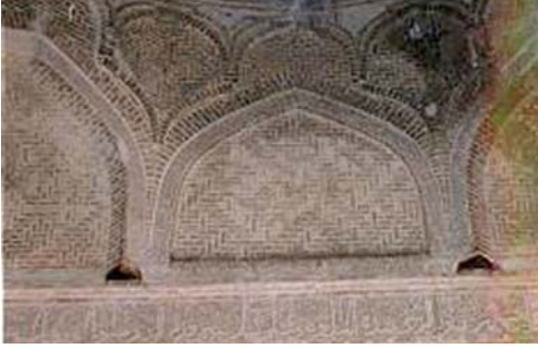
Resim 4.4. Ahşap elemanlar üzerinde yükselen trompların görünümü [SOBOUTI,H., 2007]
