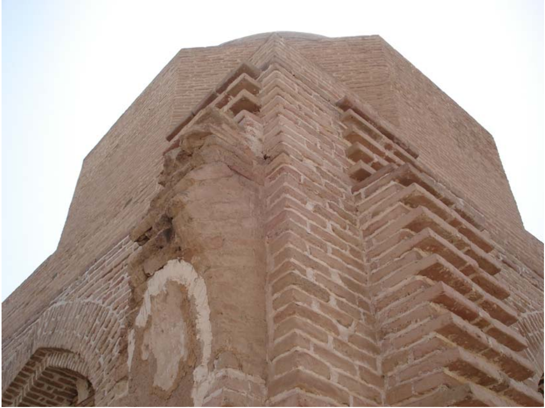
Resim 3.51. Yapıdaki izlerden örnek [SOBOUTI, H., 2007]
