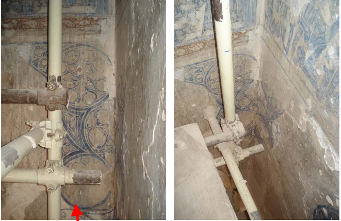
Resim 3.28. Yapının köşesinde yer alan kalem işi [SOBOUTI, H., 2007]
