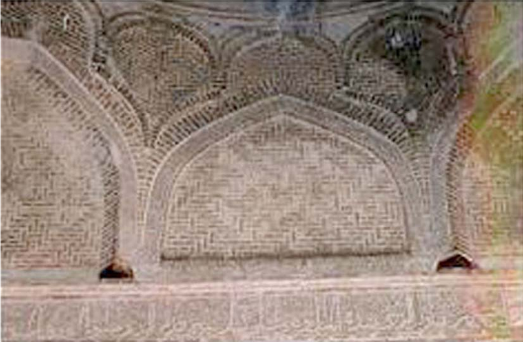
Resim 3.38. Socas Cuma Mescidi'nde yer alan tuğla işçiliği [SOBOUTI, H., 2007]
