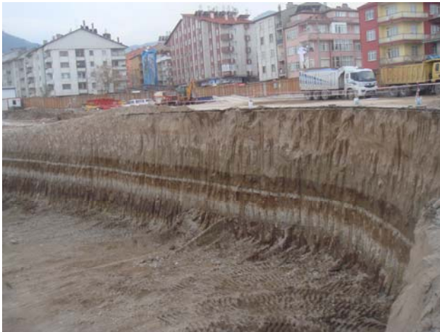
Şekil 4.20. Isparta Ovasındaki tüf ve pomza seviyelerindeki düzenli tabakalanma (Çarşamba pazarı inşaat temel kazısı)
