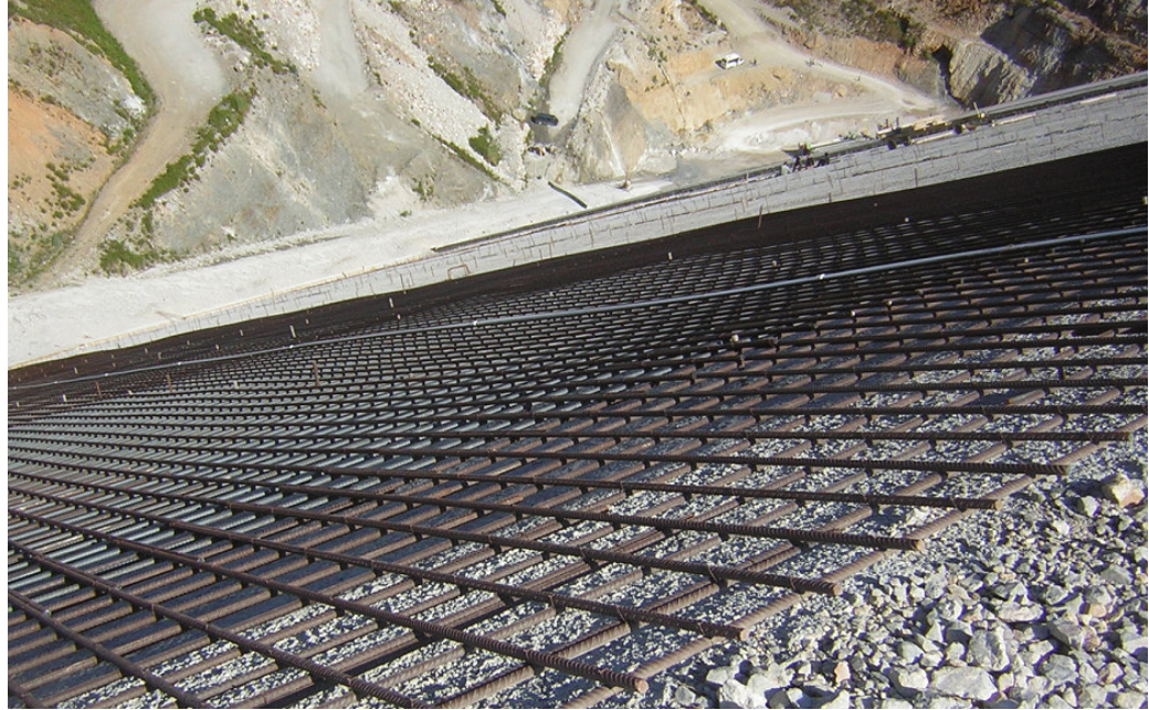
Şekil 6.3. Dim barajının kretinden memba şevinin görünümü
