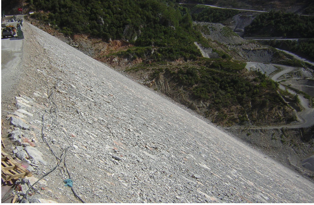
Şekil 6.4. Dim barajının kretinden mansap şevinin görünümü
