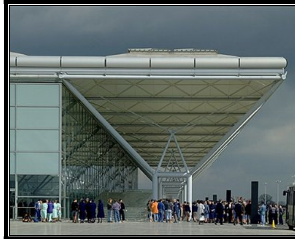
Şekil 2.36 Sainsbury Görsel Sanatlar Merkezi, Londra, 1977, Norman Foster, ( http://www.scva.org.uk )
