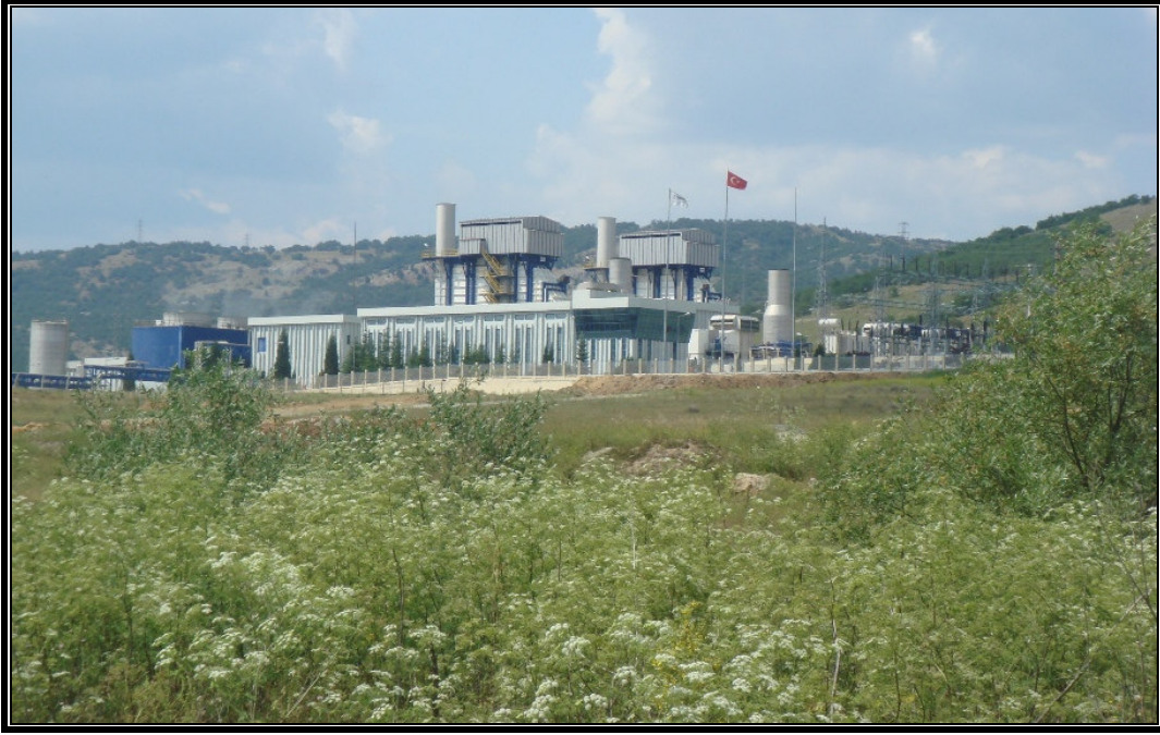
Fotoğraf 3.41. Akenerji Elektrik Üretimi A.Ş tesislerinden bir görünüm.
