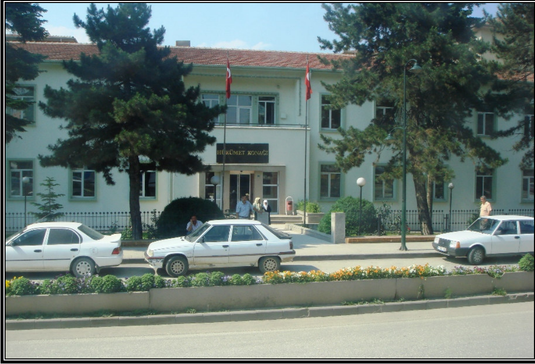
Fotoğraf 3.1. Bozüyük Hükümet Konağı'ndan bir görünüm.
