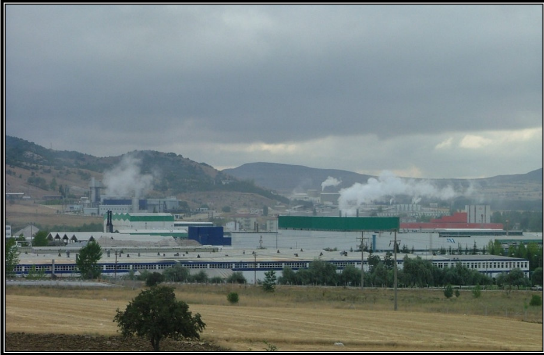
Fotoğraf 3.30. Kentin doğusunda karayolunun kuzeyinde yer alan sanayi tesislerinden genel bir görünüm.
