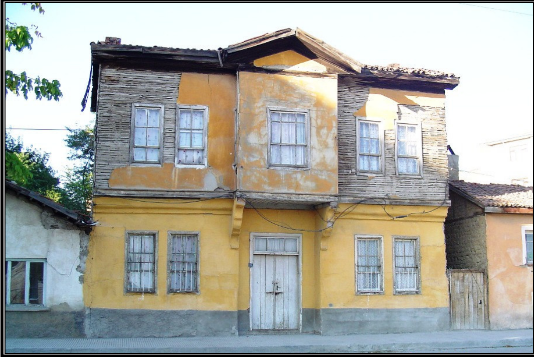
Fotoğraf 1.4. Ahşap ve kerpiç malzemeden yapılmış bir eski Bozüyük evi.
