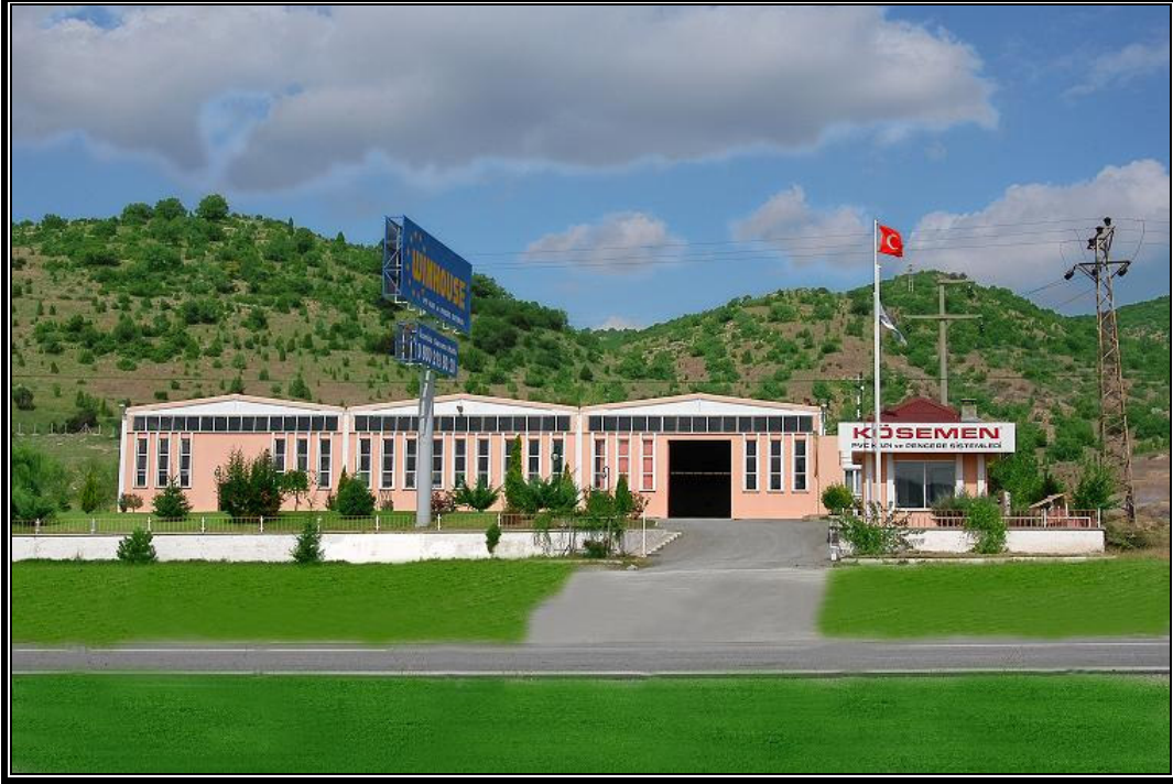
Fotoğraf 3.38. Kösemen Plastik Metal Profil Sanayi ve Ticaret A.Ş. tesislerinden bir görünüm.
