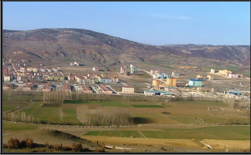
Fotoğraf 2.9. Sanayi tesisleri nedeniyle gelişim alanını batıya doğru sürdüren ve bir ucu doğudaki fabrikalara kadar uzanan, modern binaların yer aldığı 4 Eylül Mahallesi’nin güneyinden bir görünüm.
