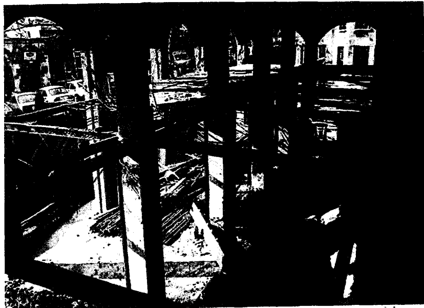
Şekil 4.30 Harikzedegan Katevleri, mağazalar bölümlerinin çelik takviye hazırlıkları
