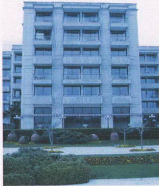
Şekil 4.17 Çırağan Sarayı, ek bina cephesi
