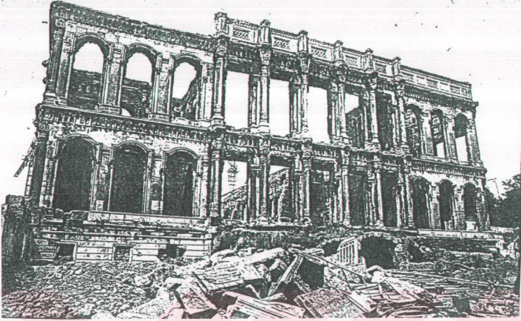
Şekil 4.16 Çırağan Sarayı, kuzey cephesi, restorasyon öncesi
