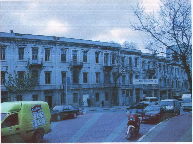
Şekil 4.5 Akaretler Blokları, inşaatı devam eden blok
