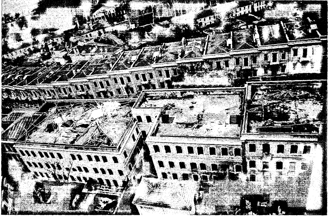
Şekil 4.23 Akaretler Blokları, çatı yenilemesi
