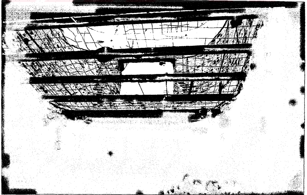
Şekil 4.26 Akaretler Blokları, döşemelerde korozyona uğramış elemanların yenilenmesi
