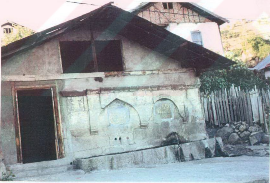
Şekil 5.7. Söğütçüpnarı isimli mahalle çeşmesi (Orijinal 2000).
