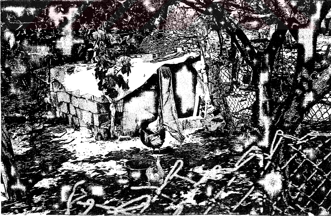
Fotoğraf 4.2. Briket, naylon örtü ve çeşitli inşaat atıkları kullanılarak yapılmış etrafi telle çevrili ve toprak zeminli bir kümes (özgün)
