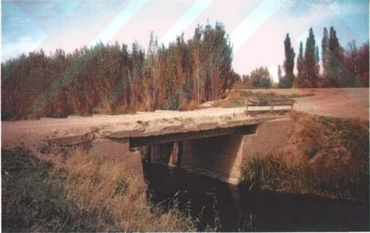
Şekil 4.1. Ana boşaltım kanalı üzerinde yapılan köprü (Soğukoluk köyü)
