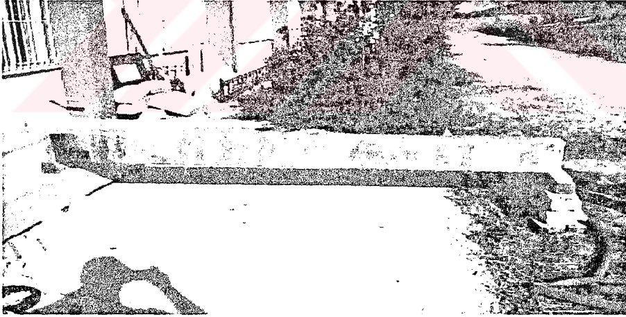
Şekil.5.39: FRP ile sargılanmış kiriş
