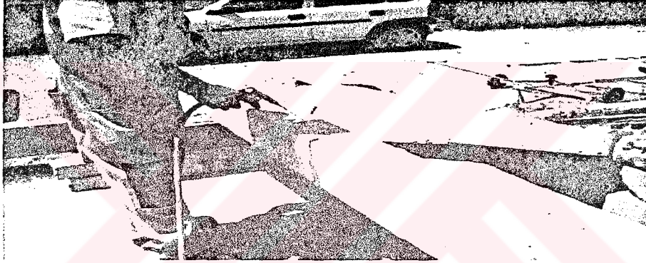
Şekil.5.26: Kiriş yüzeyinin basınçlı hava ile temizlenmesi
