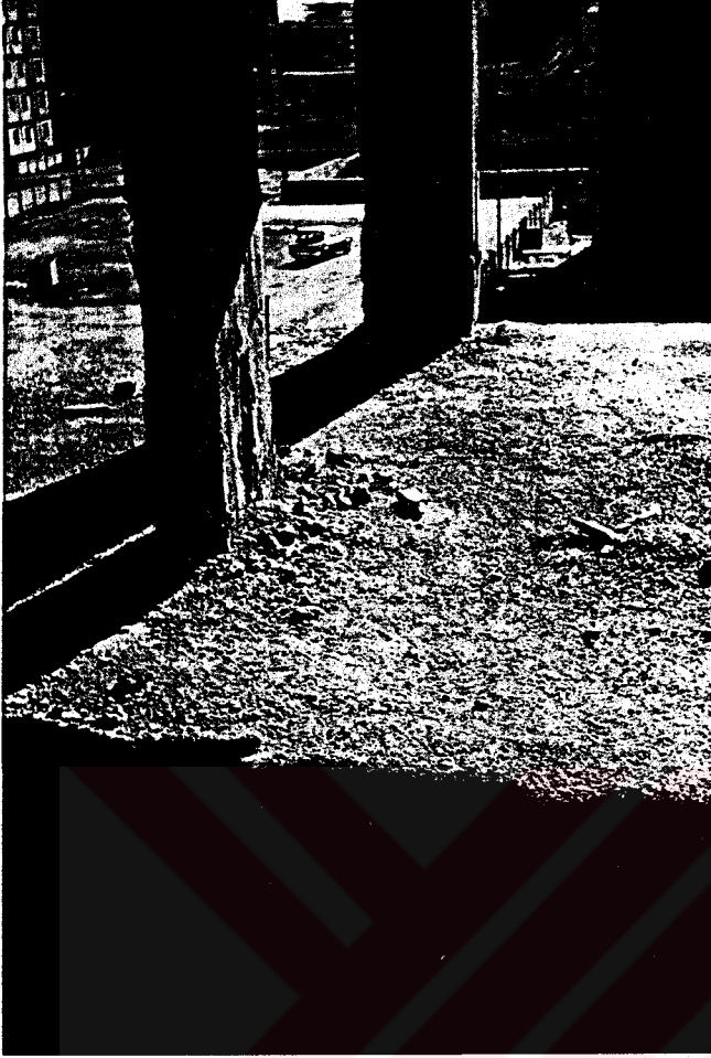
Kolonlarda Meydana Gelmiş Ezilmelere Ait Fotograf
