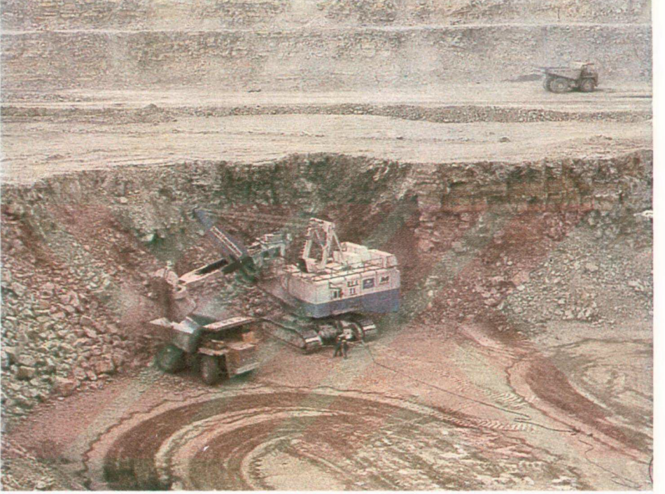
Şekil 3.2. Soma'da ekskavatör-kamyon yöntemiyle kömürün üstündeki malzemenin kaldırılması (TKİ, 2002)
