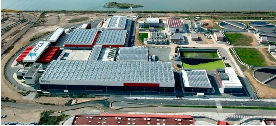
Şekil 4.5. İspanya - Barselona tuzdan arındırma tesisi
