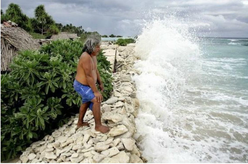
Şekil 4.7. Kiribati'de gel-git ve deniz suyu yükselmesine karşı önlem olarak deniz duvarı
