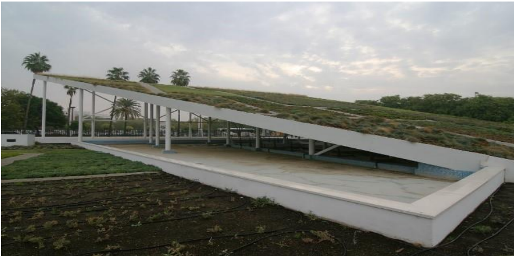
Şekil 4.15. Sevilla – İspanya’da Yeşil Çatı uygulaması
