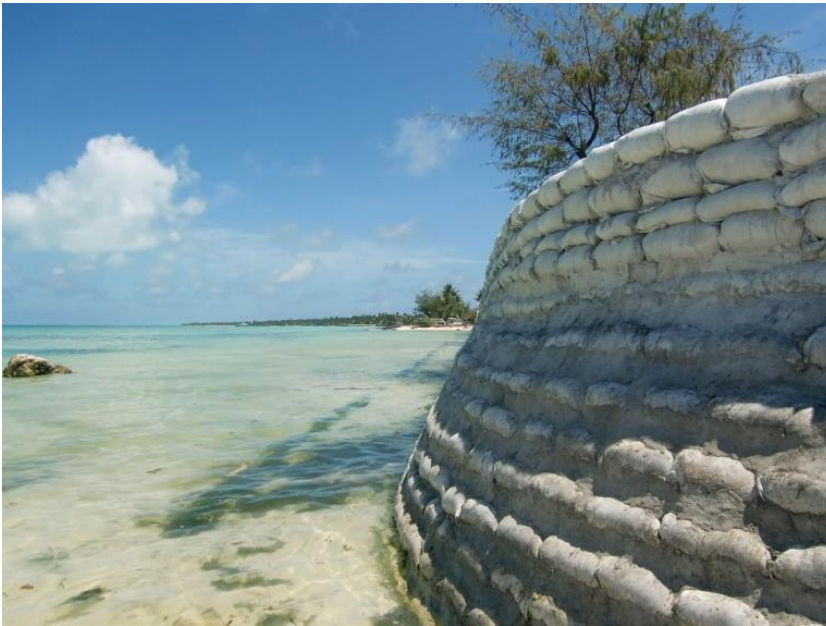
Şekil 4.8. Kiribati'de gel-git ve deniz suyu yükselmesine karşı önlem olarak deniz duvarı
