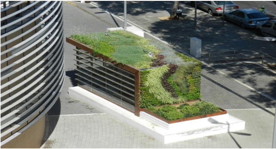
Şekil 4.14. Sevilla – İspanya’da Yeşil Çatı uygulaması
