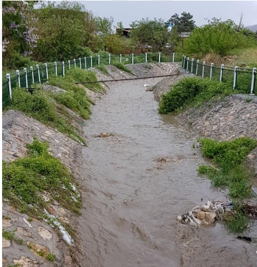
Şekil 6.1. Horata Deresi taş uygulaması ile kaplanması
