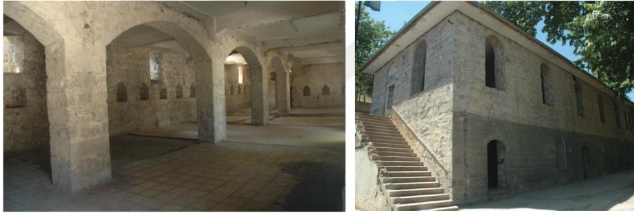
Şekil 4.24..Jandarma İstihbarat Binası İstinada çıkan Merdiven (Soyukaya, 2012)
