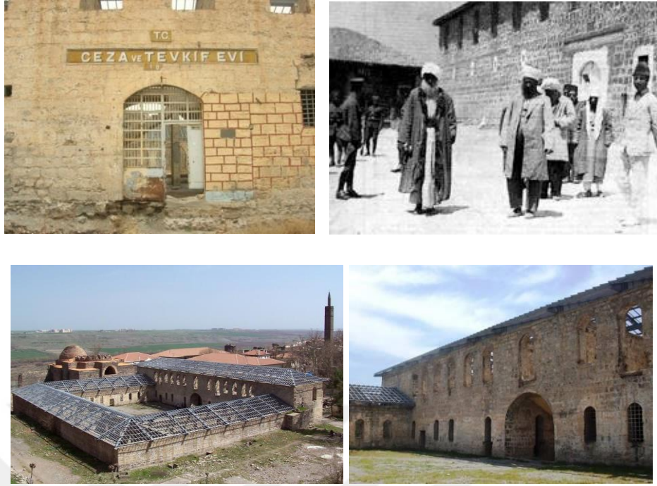
Şekil 4.17. Diyarbakır İçkale Eski Cezaevi Binası (Diyarbakır müze müd. Arşiv)
