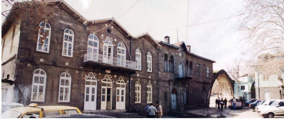
Şekil 4.25. Diyarbakır İçkale Karakol Binası Güney cephesi (Diyarbakır KVKBKM Arşivinden )
