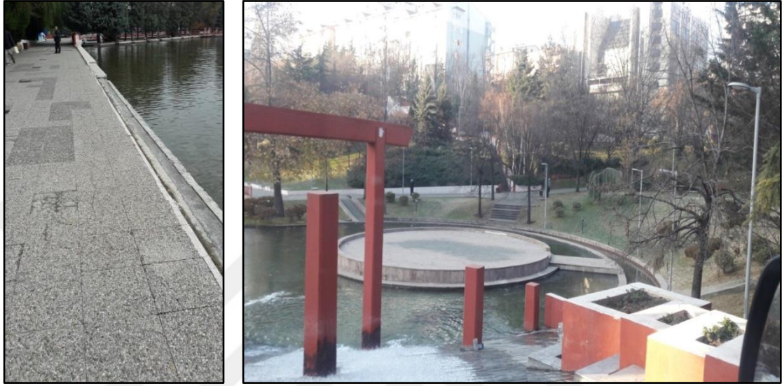
řekil 4.3 Dikmen Vadisi Parkı 1.Etap gvenlik nlemleri alınmayan havuz kenarları (Orijinal 2018)
