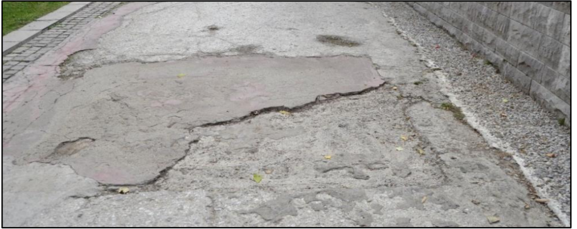
Şekil 4.7 Kabarma nedeniyle oluşmuş zemin bozuklukları (Orijinal 2018)
