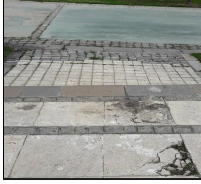
Şekil 4.5 Kırılma nedeniyle oluşmuş zemin bozuklukları (Orijinal 2018)
