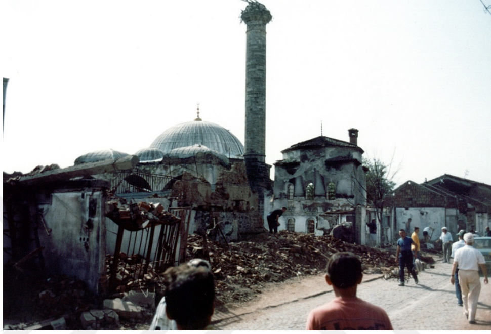
Şekil 11. Yakova. Hadım Camii. 1998/1999 savaşında zarar görmüş hali. (IHKL, 1999)
