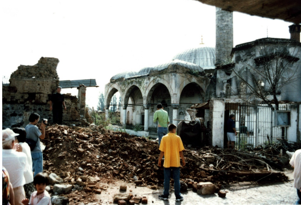
Şekil 12. Yakova. Hadım Camii. 1998/1999 savaşında zarar görmüş hali. (IHKL, 1999)
