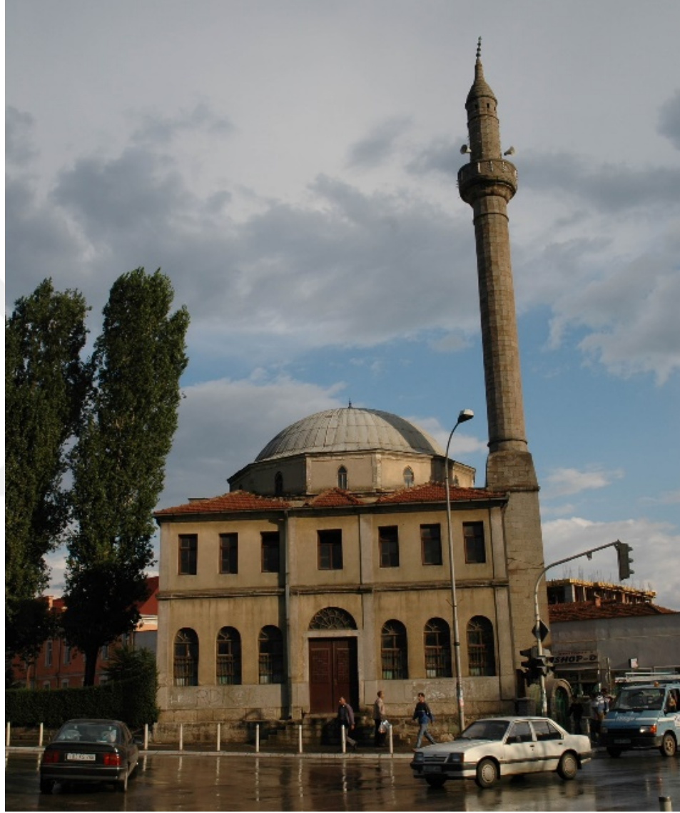
Şekil 18. Priştine. Çarşı Camii. Restorasyondan önce. (Afrim Hajrullahu, IKMMK)
