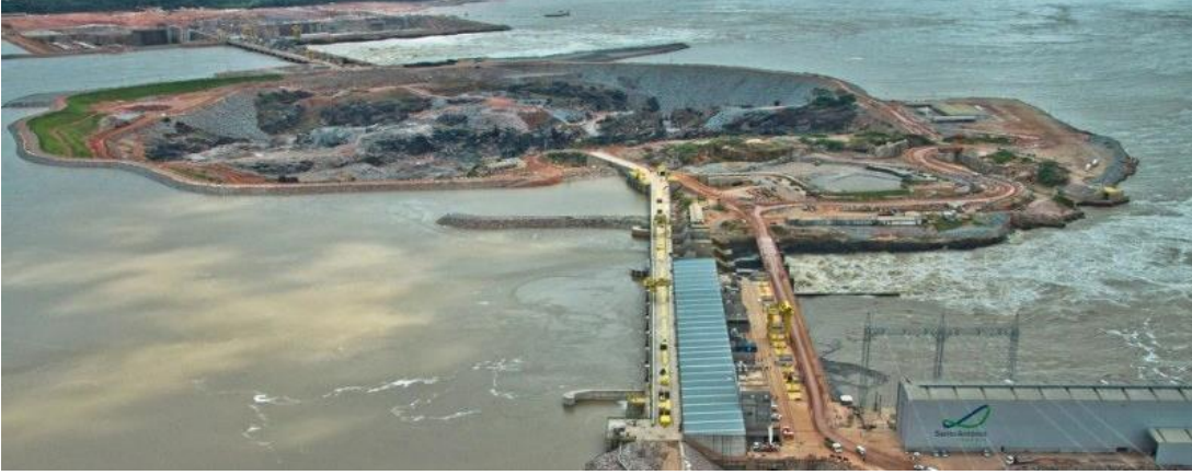
Şekil 3.33 : Santo Antonio Barajı (Brezilya).
