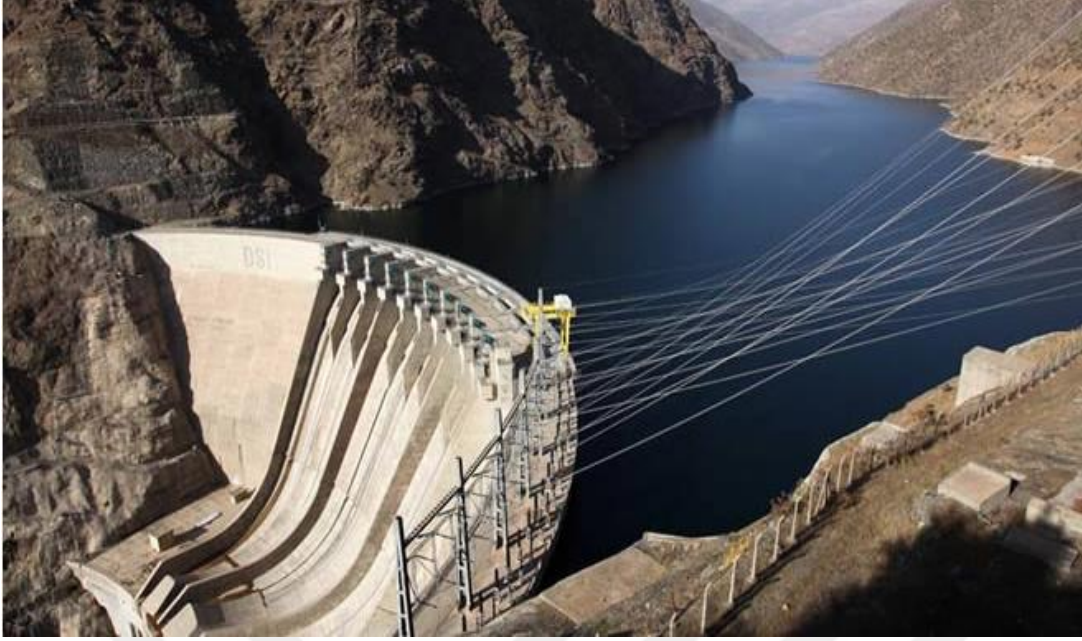
Şekil 3.40 : Karakaya Barajı (Fırat - Türkiye).
