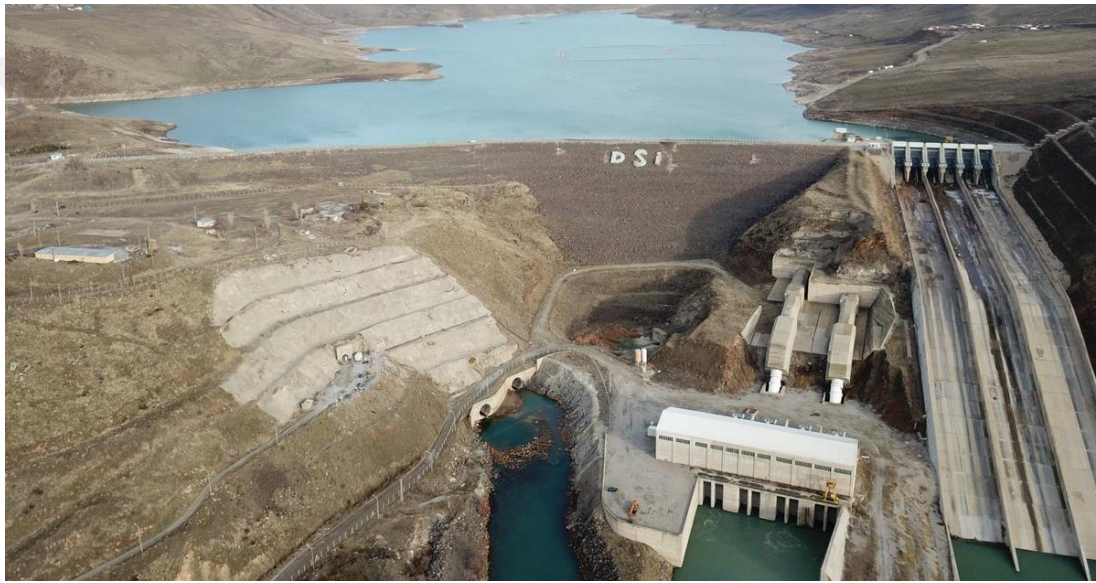
Şekil 3.46 : Alparslan 1 Barajı (Murat - Türkiye).
