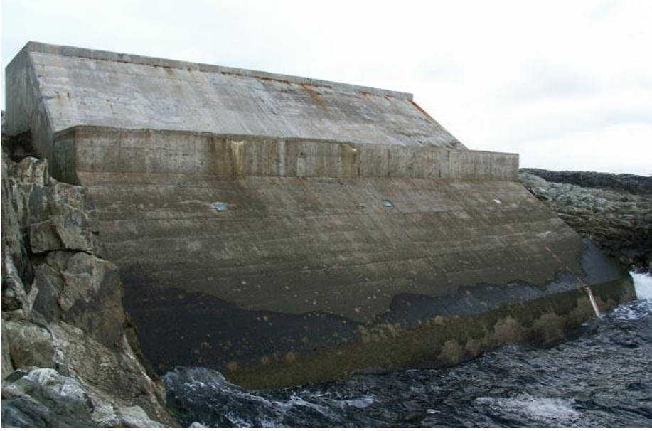
Şekil 3.55 : İslay Dalga enerji üreten santralin dış görünümü (İskoçya).
