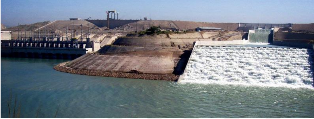
Şekil 3.47 : Ghazi-Barotha Nehir tipi hidroelektrik santrali.
