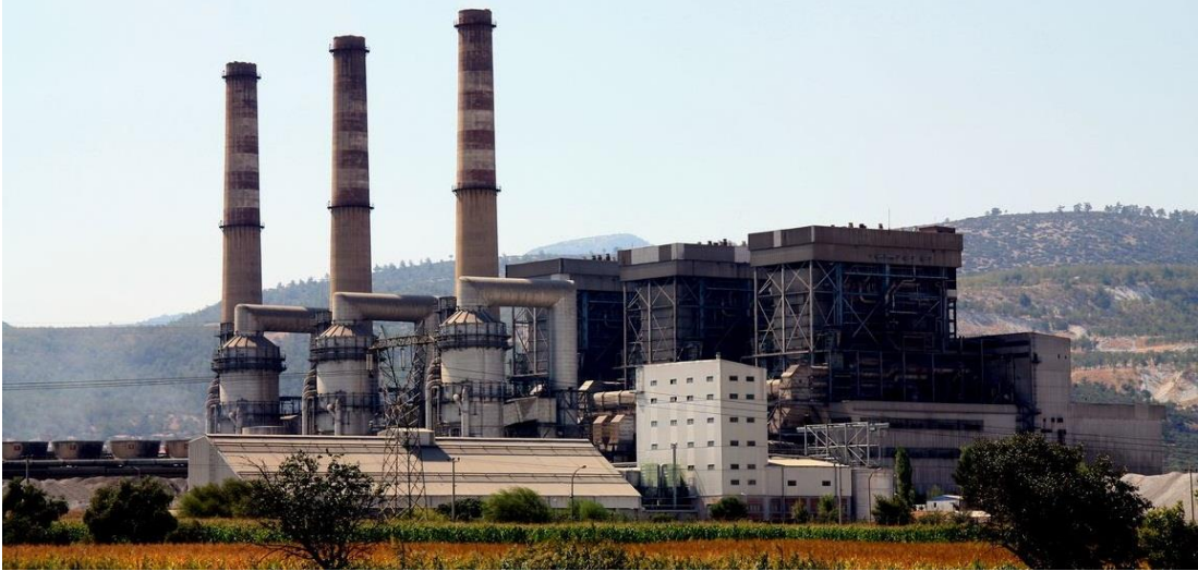
Şekil 3.23 : Yatağan termik santrali.
