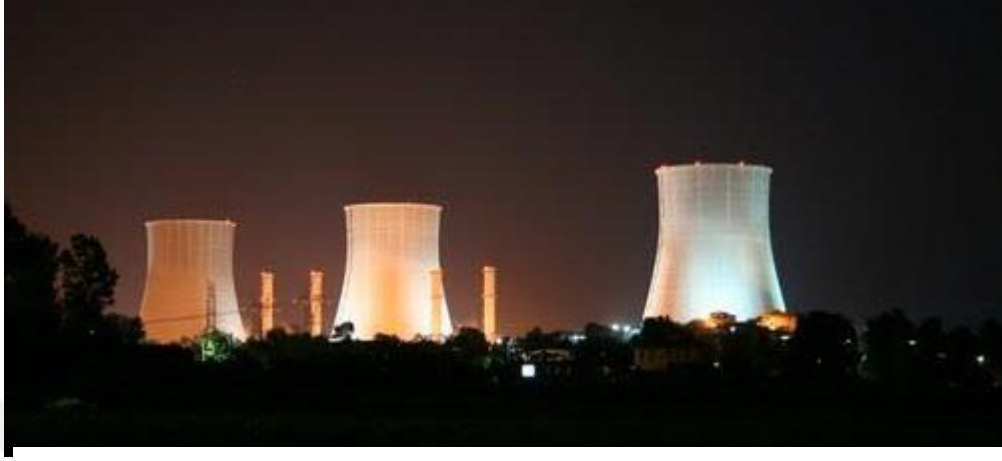
Şekil 3.20 : Enka Doğal Gaz Çevrim Santrali (Gebze).
