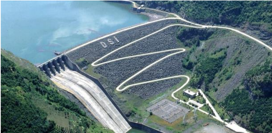
Şekil 3.41 : Hasan Uğurlu Barajı (Yeşilirmak - Türkiye).
