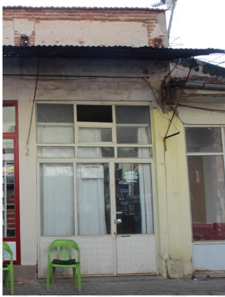
Fotoğraf 87: 14. Dükkan Batı Cephe (2018).
