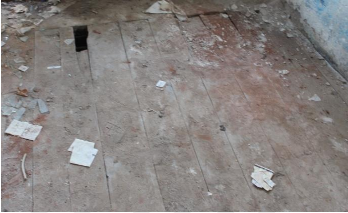
Fotoğraf 99: 16. Dükkanın Zemin Kat Yer Döşemesi (2018).
