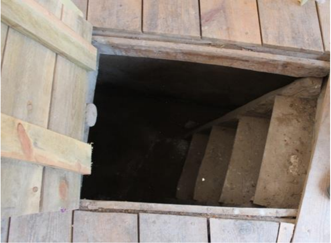
Fotoğraf 28: 5. Dükkan Bodrum Kata İnişi Sağlayan Merdiven Açıklığı (2018).
