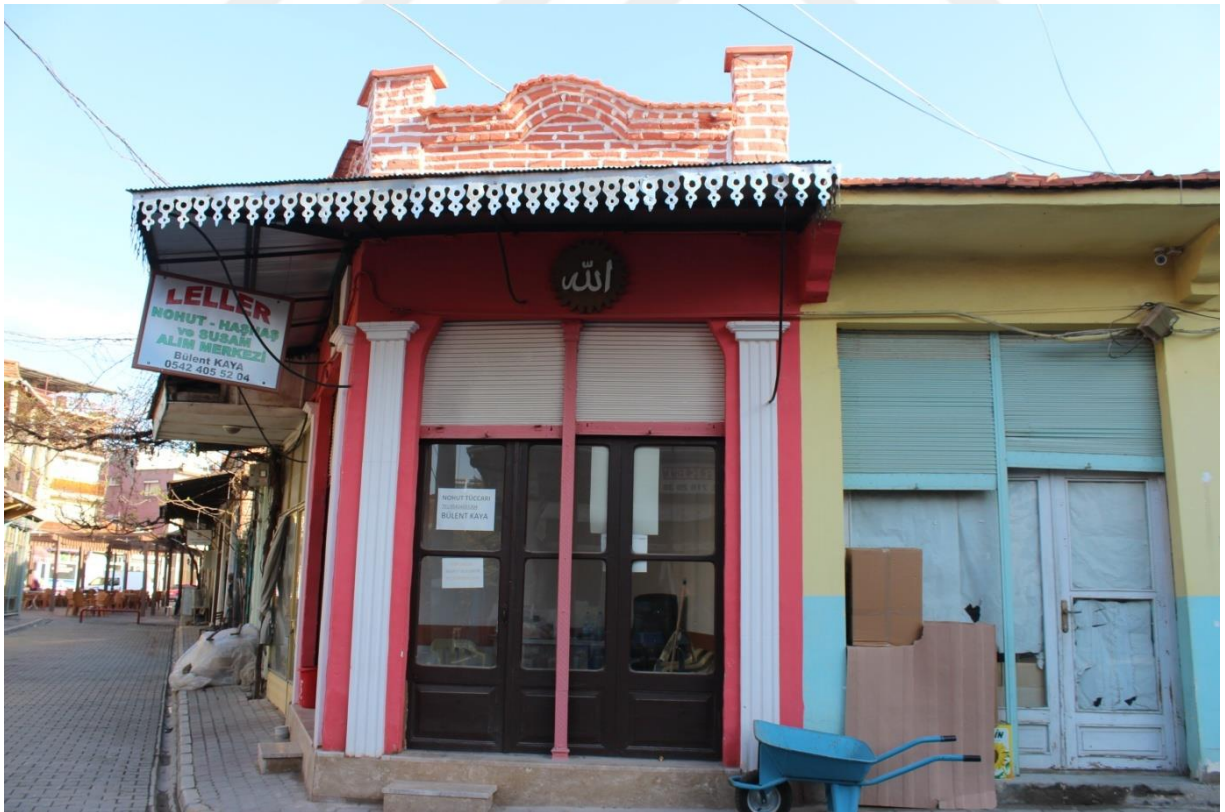
Fotoğraf 32: 5. Dükkan Güney Cephe 2018).
