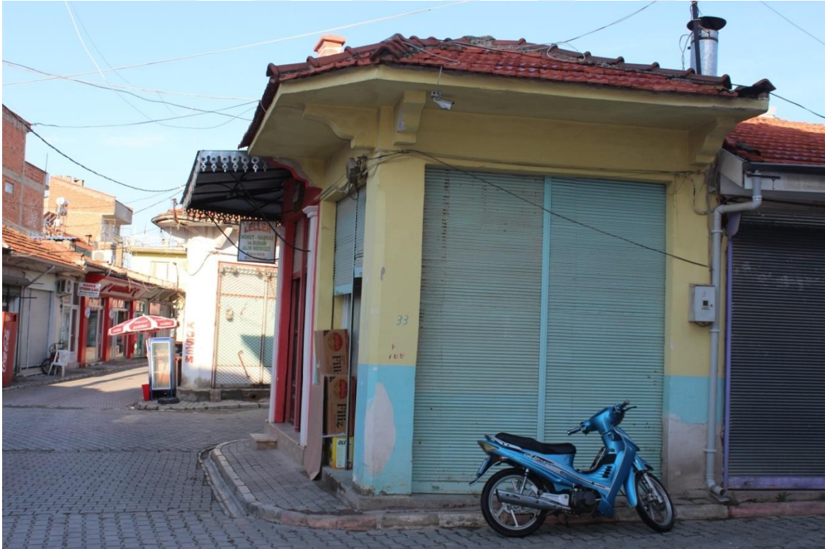
Fotoğraf 18: 3. Dükkan Doğu Cephe (2018).
