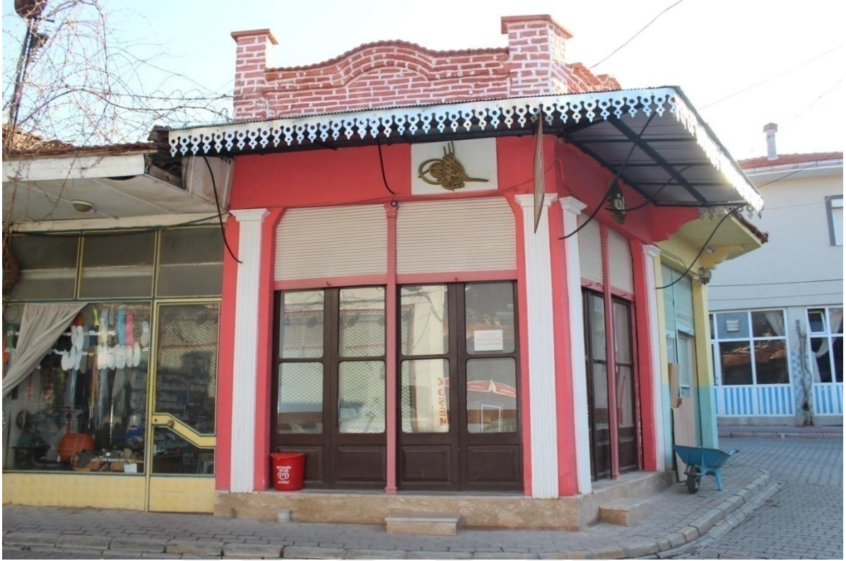
Fotoğraf 31: 5. Dükkan Batı Cephe (2018).
