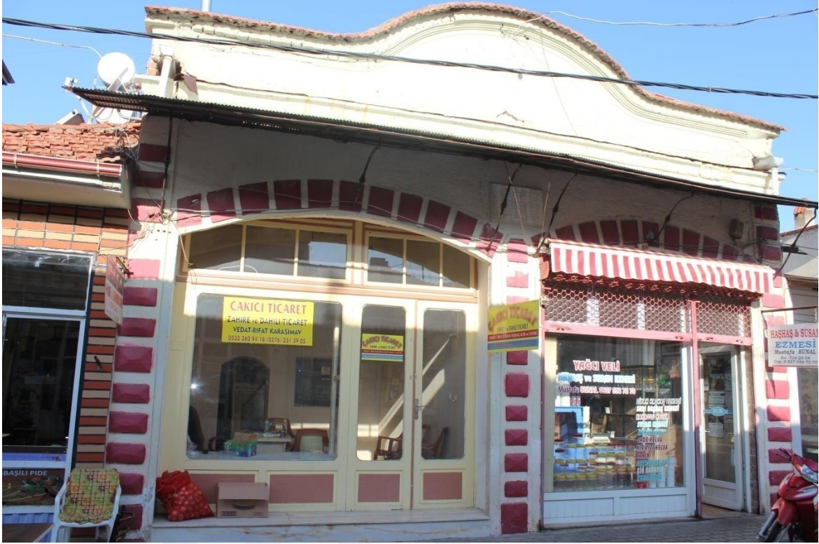
Fotoğraf 103: 18. Dükkan Doğu Cephe (2018).
