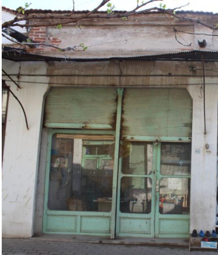
Fotoğraf 50: 8. Dükkan Batı Cephe (2018).
