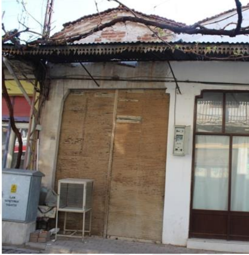
Fotoğraf 59: 10. Dükkan Batı Cephe (2018).
