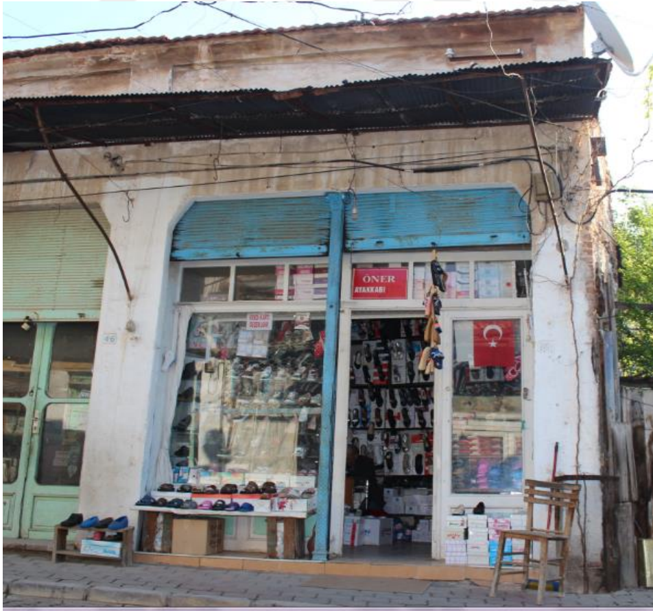
Fotoğraf 44: 7. Dükkan Batı Cephe (2018).
