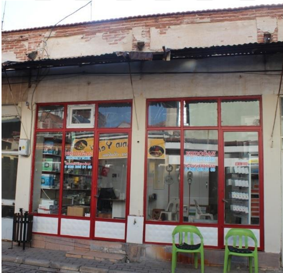
Fotoğraf 92: 15. Dükkan Batı Cephe (2018).
