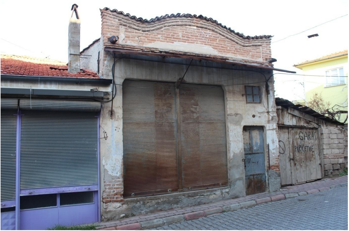
Fotoğraf 23: 4. Dükkan Doğu Cephe (2018).
