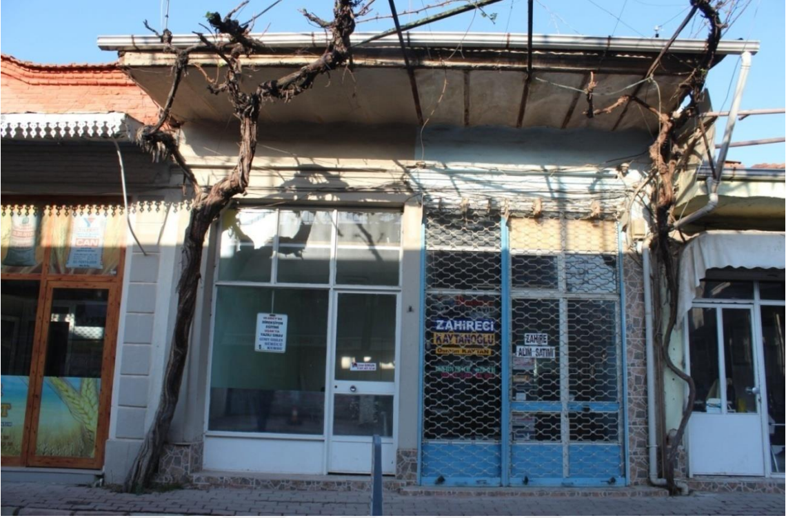
Fotoğraf 11: 2. Dükkan Doğu Cephe (2018).
