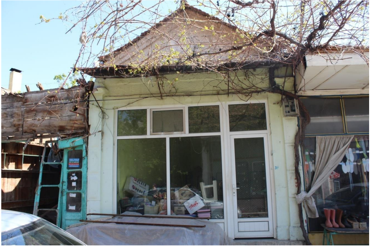
Fotoğraf 38: 6. Dükkan Batı Cephe (2018).
