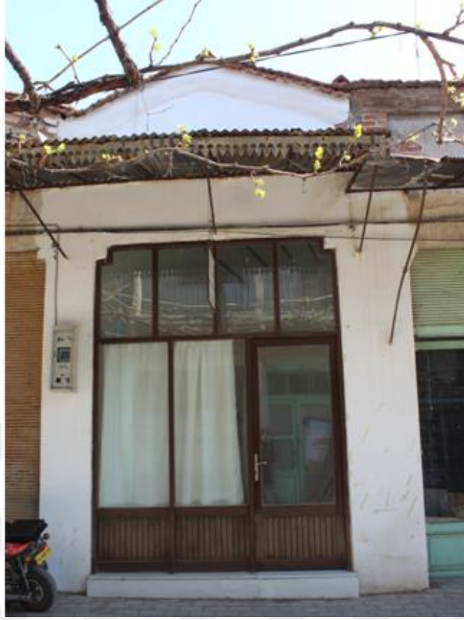
Fotoğraf 55: 9. Dükkan Batı Cephe (2018).
