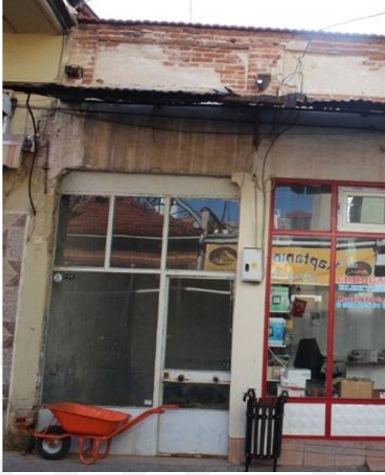
Fotoğraf 97: 16. Dükkan Batı Cephe (2018).
