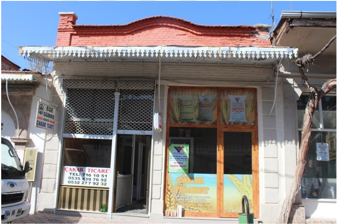
Fotoğraf 4: 1. Dükkan Doğu Cephe (2018).
