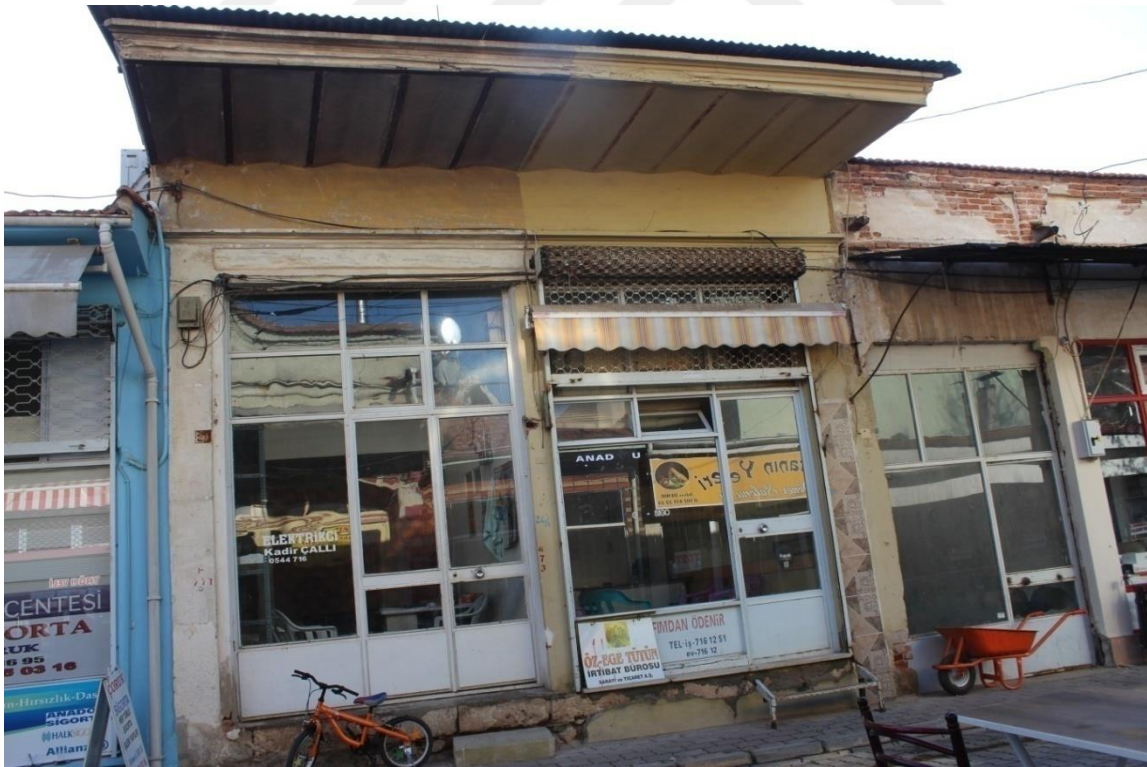
Fotoğraf 100: 17. Dükkan Batı Cephe (2018).
