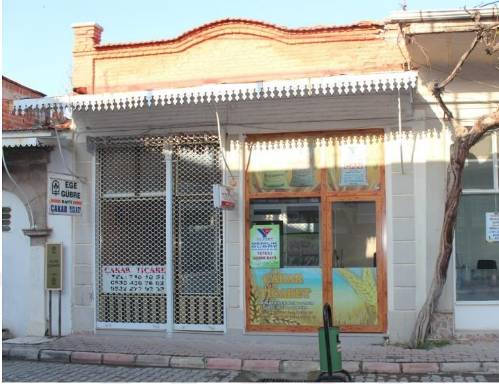
Fotoğraf 1: 1. Dükkan Doğu Cephe (2018).
