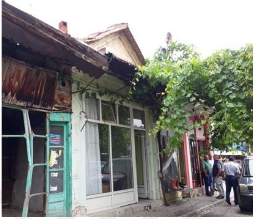
Fotoğraf 39: 6. Dükkan Batı Cephe (2018).
