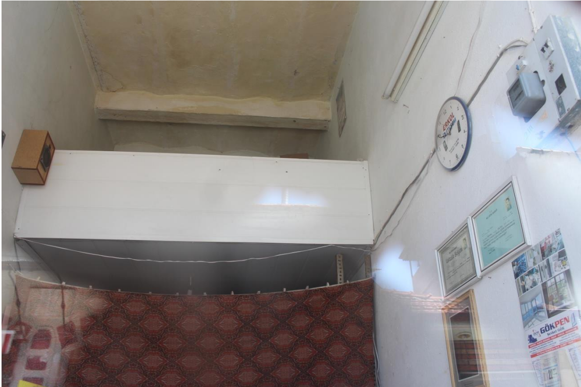
Fotoğraf 102: 17. Dükkan Kuzey Bölümü İçten Görünüşü (2018) 543 .
