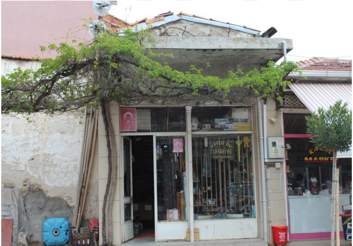
Fotoğraf 76: 12. Dükkan Batı Cephe (2018).
