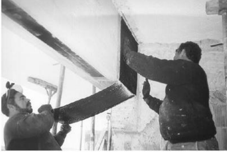
Şekil 3. 18 Islak uygulama tekniği [84]
