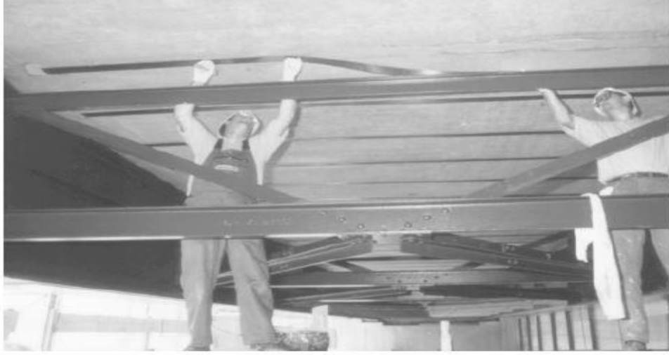
Şekil 3. 17 FRP şerit uygulaması [84]
