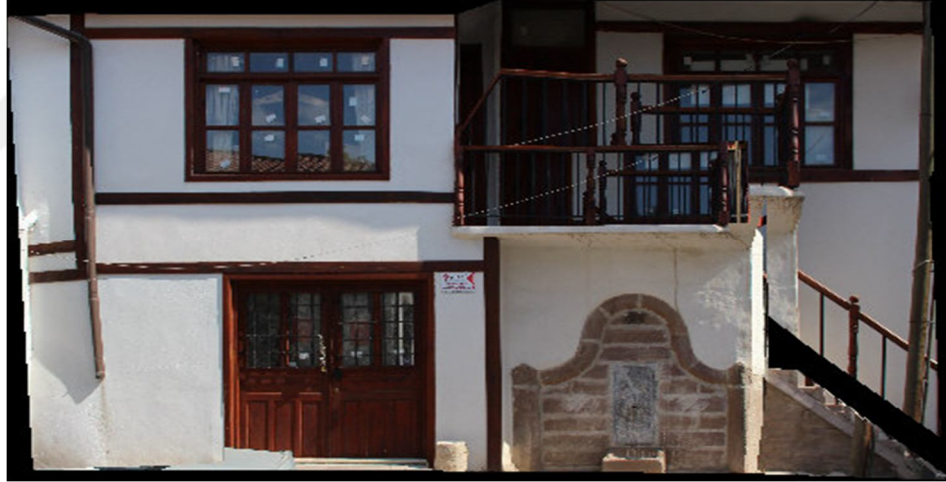
Şekil 3.30: Konya Çalışma Sahası Yersel Fotogrametri İle Binanın Batı Cephesine Ait Ortofotosu
