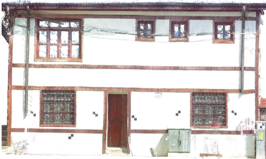
Şekil 3.15: Konya Çalışma Sahası Yersel Lazer Tarama İle Binanın Güney Cephesine Ait Ortofotosu
