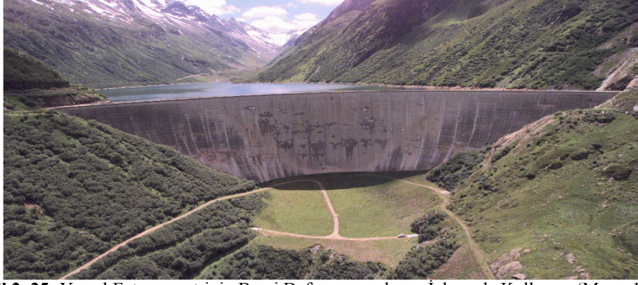
Şekil 2. 25: Yersel Fotogrametrinin Baraj Deformasyonlarını İzlemede Kullanımı(Maas, 1998)
