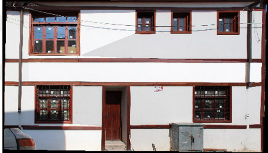
Şekil 3.25: Konya Çalışma Sahası Yersel Fotogrametri İle Binanın Güney Cephesine Ait Ortofoto
