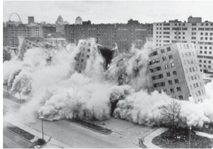
Şekil 60: Pruitt-Igoe konut kompleksinin dinamitlerle patlatılması, 1972.
