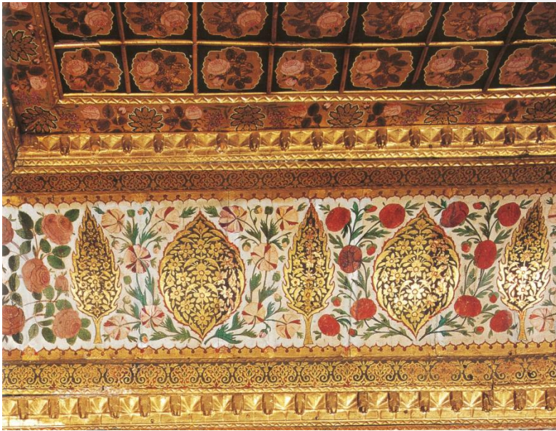
Şekil 5.29. Topkapı Sarayı Hareminde yer alan III.Ahmed'in Hasodası (Yemiş Odası) ve tavandaki servi motifleri. Kaynak: Atasoy, Hasbahçe s.121.
