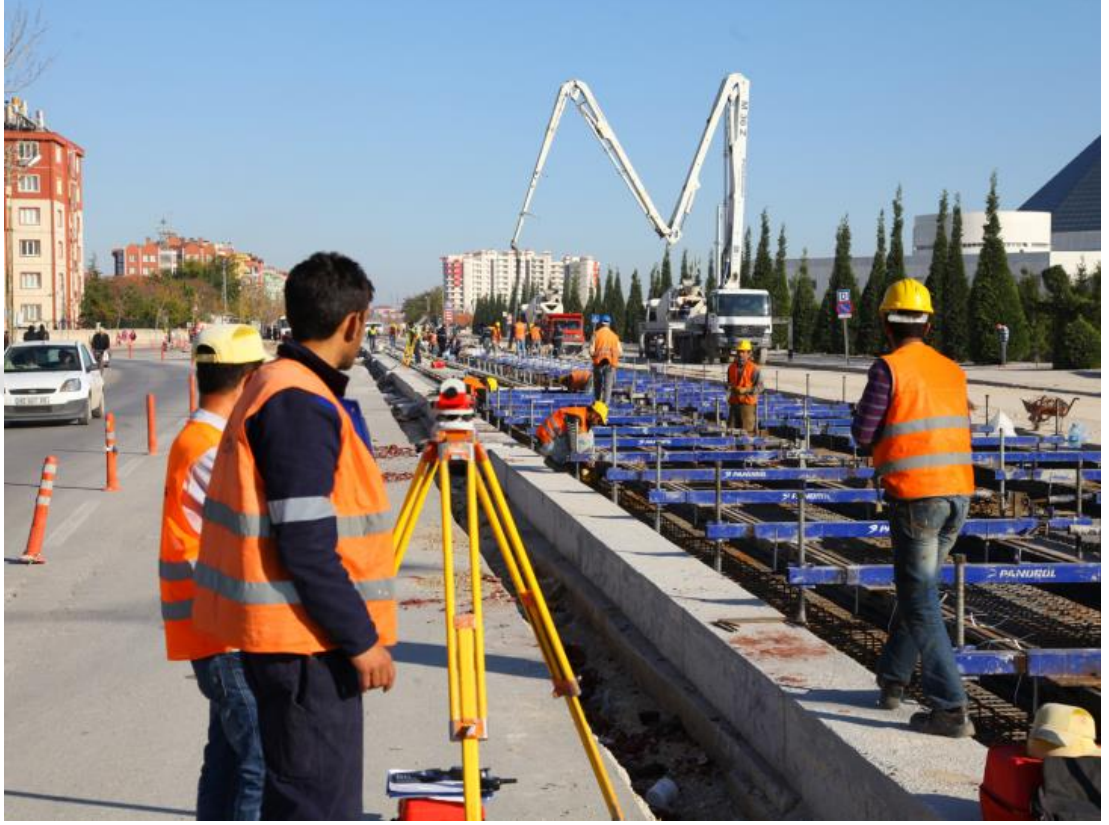
Şekil 6.26: Alaadin-Adliye arası tramvay hattı yapımında CDM-JIG’lerin ayarlanması [64].
