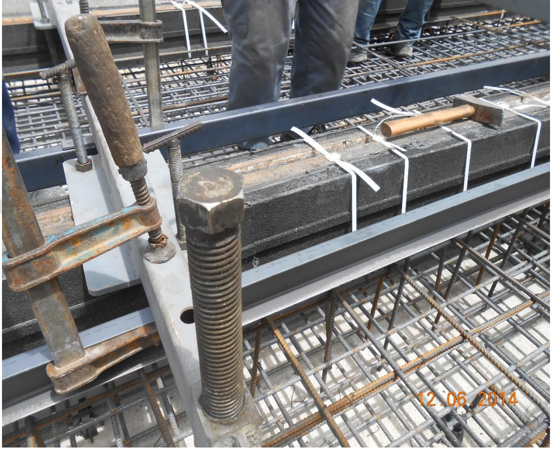
Şekil 6.28: Alaadin-Adliye arası tramvay hattı yapımında CDM-BEAM’lerin ayarlanması.
