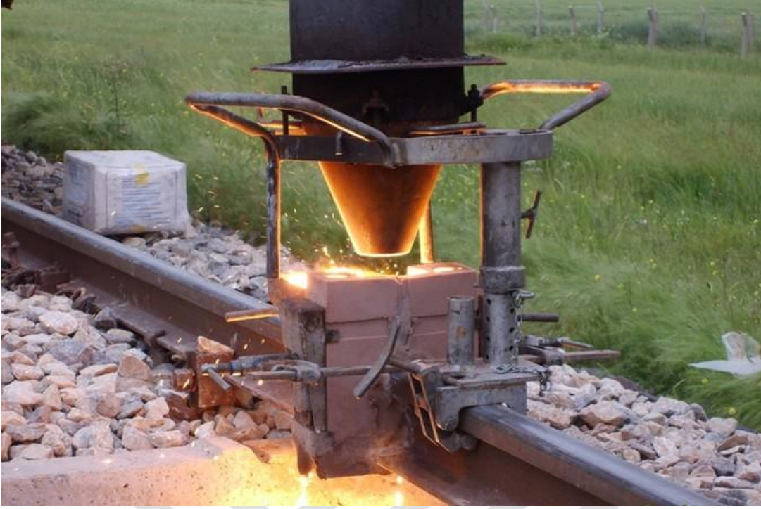
Şekil 6.6: Alüminotermite ray kaynağı yapımı [40].
