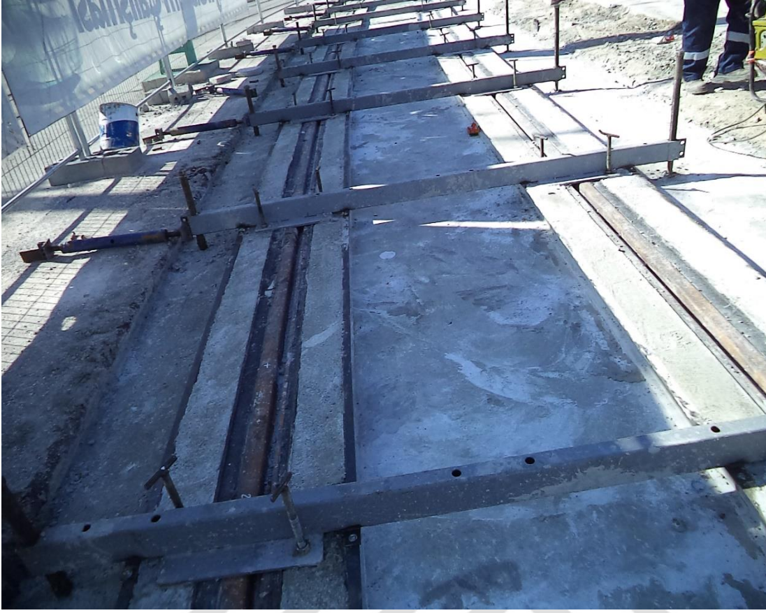
Şekil 6.29: Alaadin-Adliye arası tramvay hattı yapımında CDM-SLAB'lerin görüntüsü.
