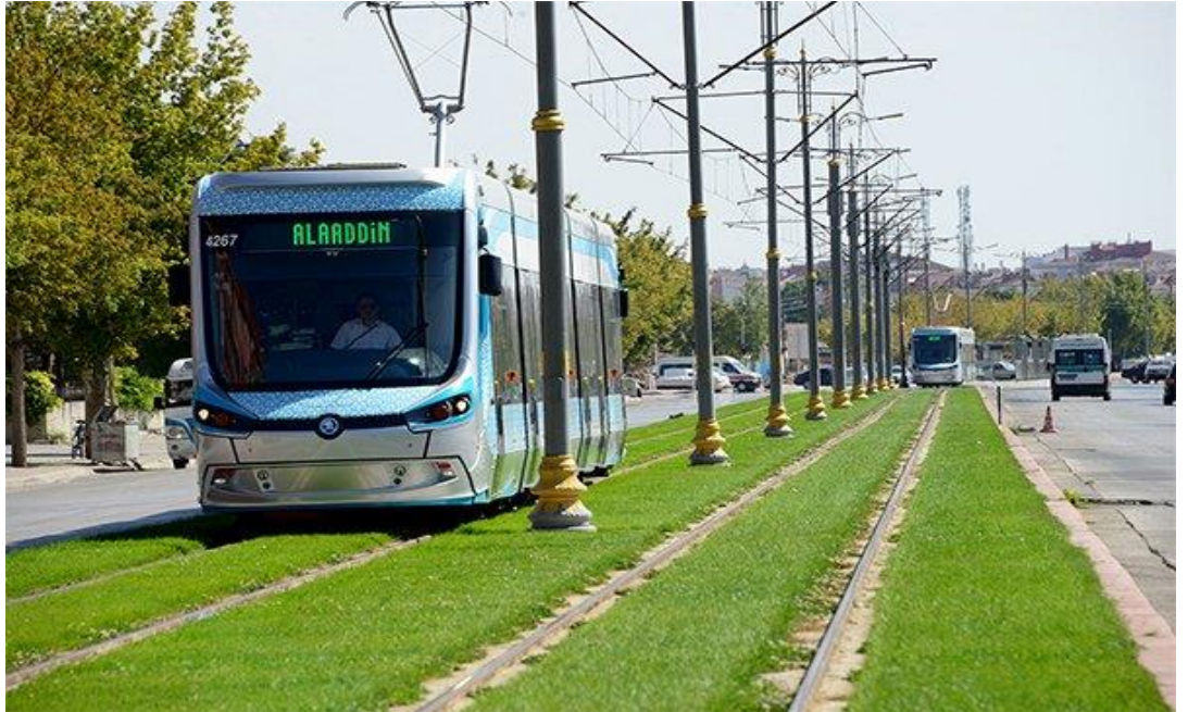
Şekil 6.24: Alaaddin-Adliye tramvay hattındaki çimli hatta ait görsel [59].
