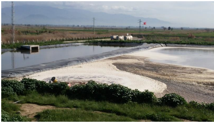
Şekil 3.4. Biyogaz tesisine ait sıvı atık ünitesi
