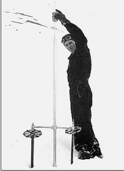
Resim 3.1. Ram (çarpma) etkisi ile penetrometre ölçümü yapan aletlerin 1939 yılında yapılan ilk örnekleri (URL10: http://www.webcitation.org/73BraLSWt )
