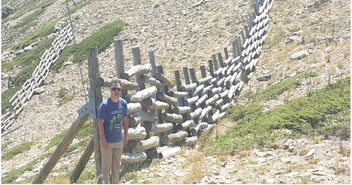
Resim 5.9. Bozdağ zirvesindeki çığ önlem yapıları
