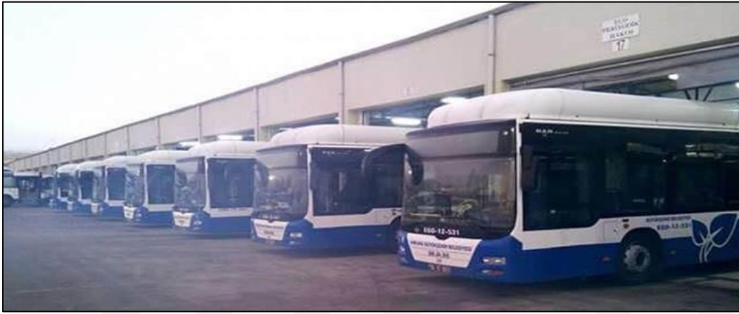
Resim 3.4. Merkez Atölye ana binadan görünüş
