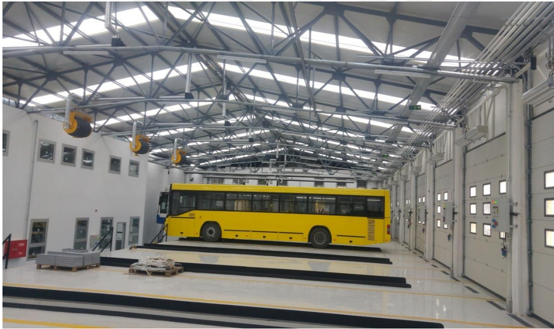
Resim 4.1. Elektrikhane binası çatının şeffaf sandviç panel ile revize edilmiş görüntüsü
