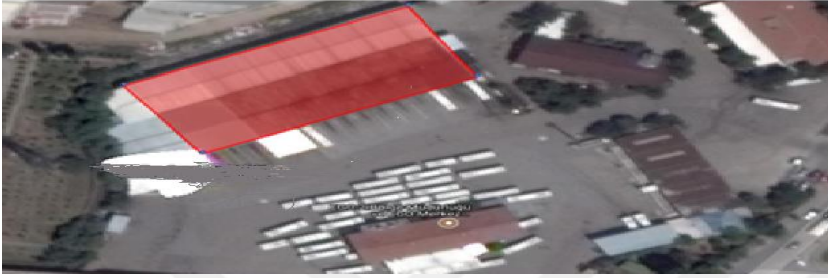
Şekil 3.17. Elektrikhane Binası üst görünüşü
