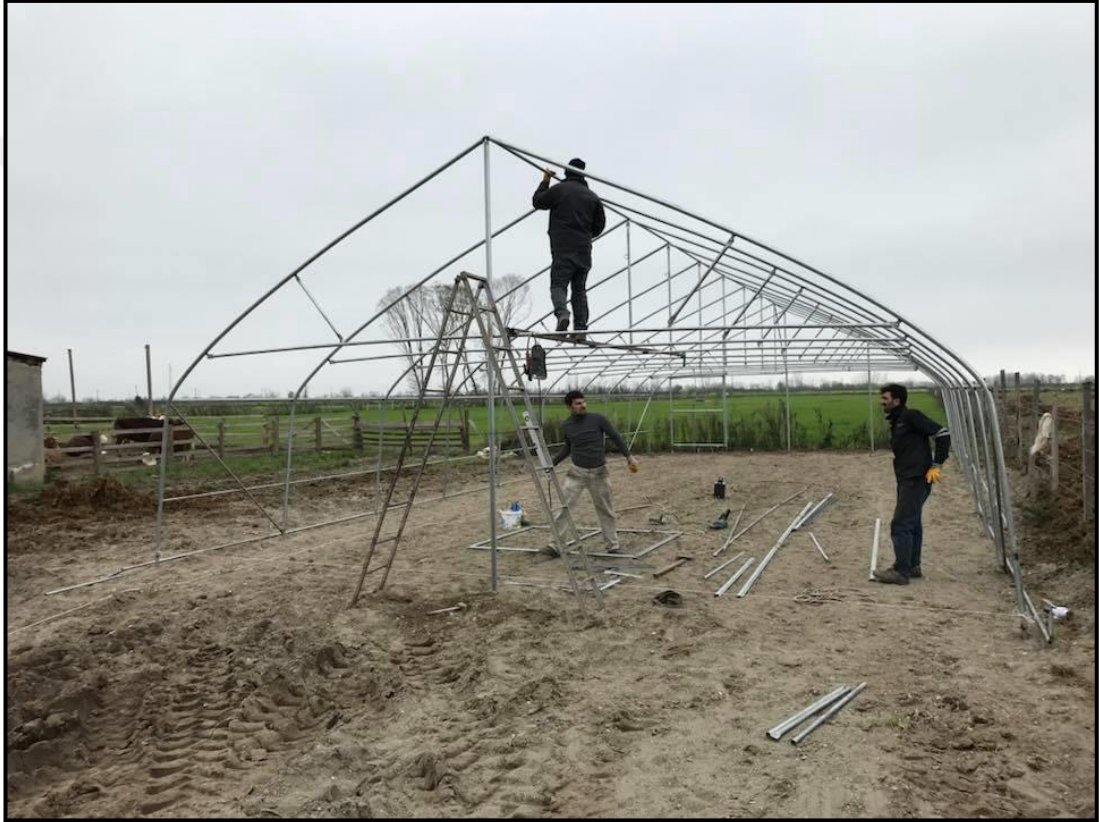
Şekil 73. Bafra Karpuzlu Mahallesi sera kurulumu
