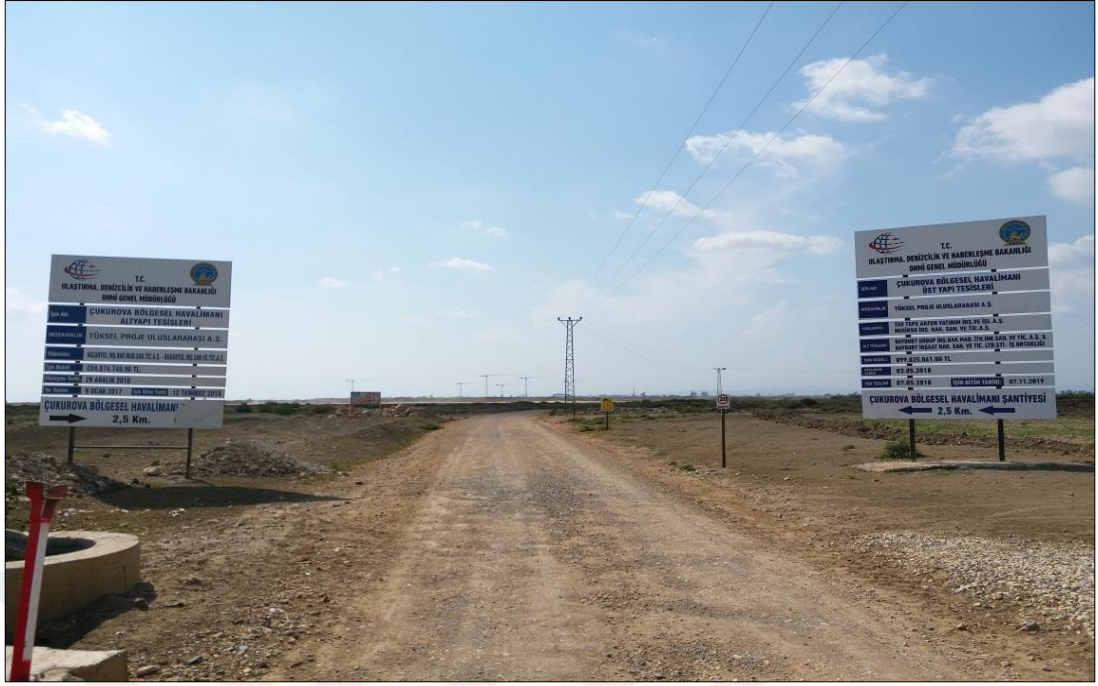
Foto 44. Karsavran Mahallesine yapılmaya başlanan Çukurova Bölgesel Havalimanı
