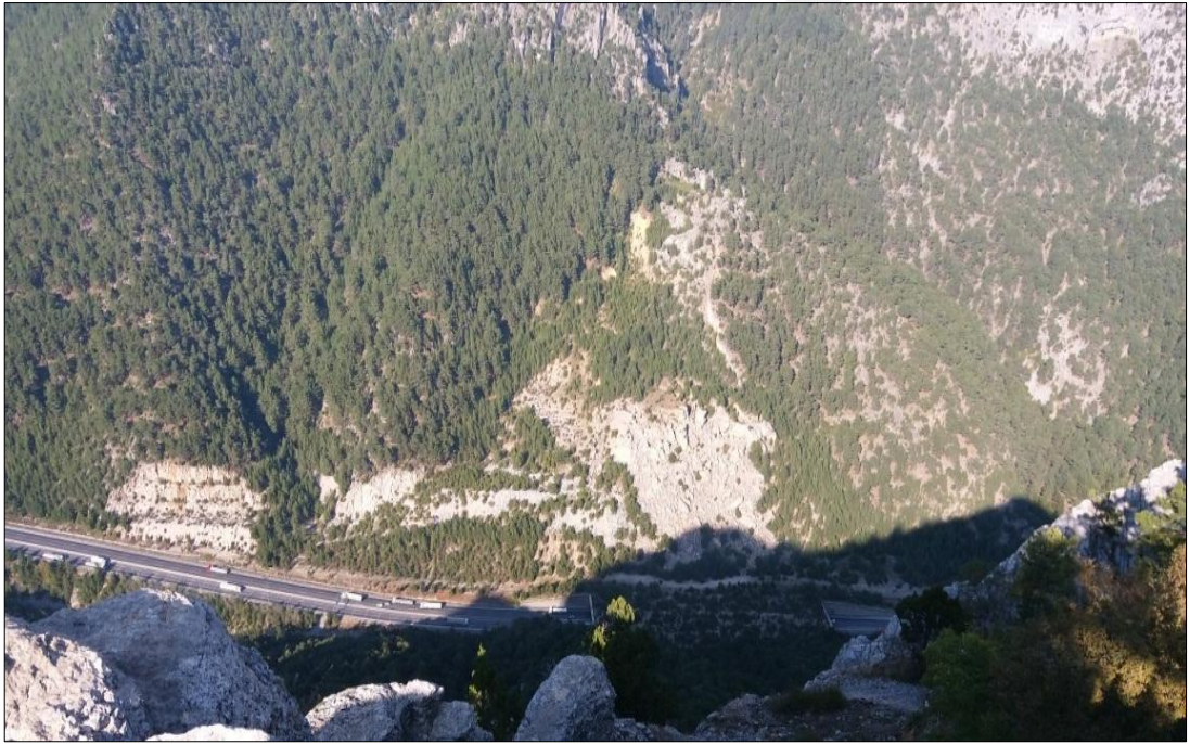
Foto 60. Yöredeki doğal hayatın kesintiye uğramaması için Gülek Boğazı mevkiine yapılan Ekosistem Köprüsü
