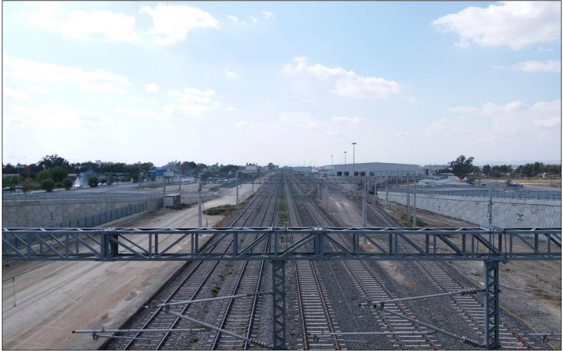
Foto 43. Adana-Mersin Demiryolu üzerinde Yenice mevkiinde D400 Karayolu kenarında yapılan Yenice Lojistik Merkezi
