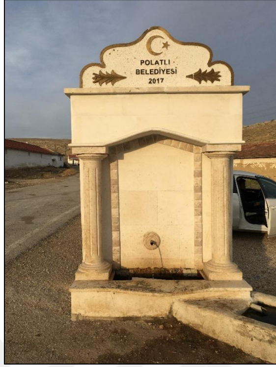
Şekil 5.8 Yenimehmetli köy çeşmesi (PKH-8) (Resimde güneye bakılmaktadır)
