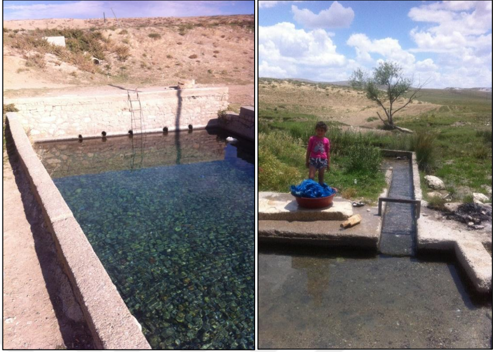
Şekil 5.34 Ilıcınar kaynağının kaptajı (1.Resimde kuzeye bakılmaktadır, 2. Resimde güneye bakılmaktadır.)
