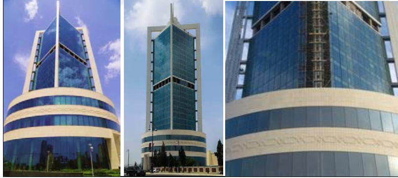
5.37. Sofaz Kulesinin Görünüşü (URL-70)
