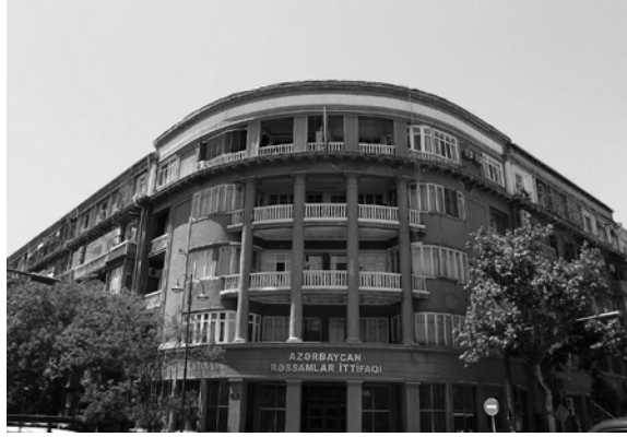
Şekil 4.54. Azerbaycan Ressamlar ittifak binası, (Aliyev, 2013)
