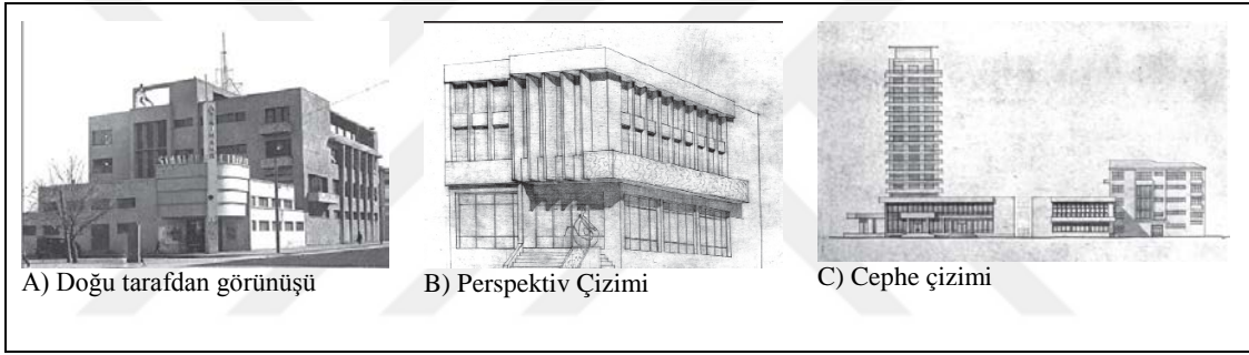
Şekil 4.40. Dinamo İdman Topluluğu Binası (1930), (Mimar-Konstüentin Sençixinin), (Aliyev, 2013)
