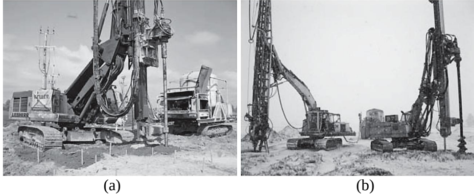
Şekil 2.16. Derin kuru karıştırma yöntemi, a) Keller/LCM ekipmanı, b) Kışın kuru karıştırma (Kirsch and Bell 2012)
