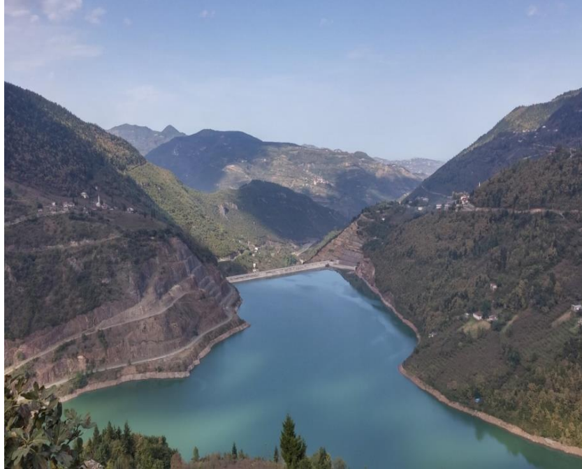
Şekil 3.1. İnşa edilen baraj (Karagüzel vd, 2003).
